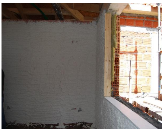
Figura 53 - Aplicação de isolamento nas paredes [14]
