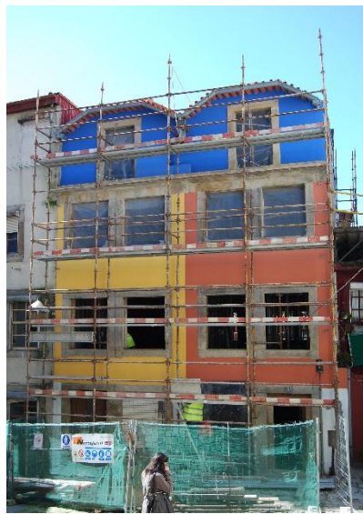
Figura 74 - Fachada do Largo da Pena Ventosa [17]
