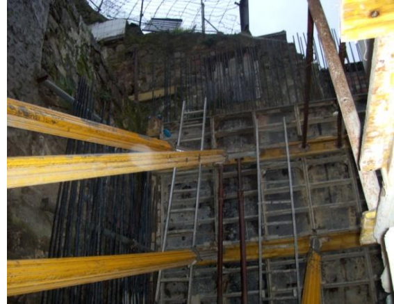
Figura 44 - Execução de muro de suporte
