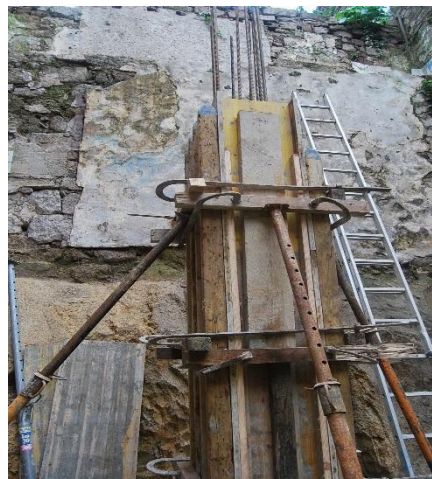
Figura 40 - Execução de pilar [14]
