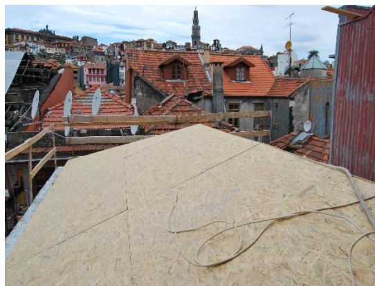
Figura 94 - Colocação das placas OSB
