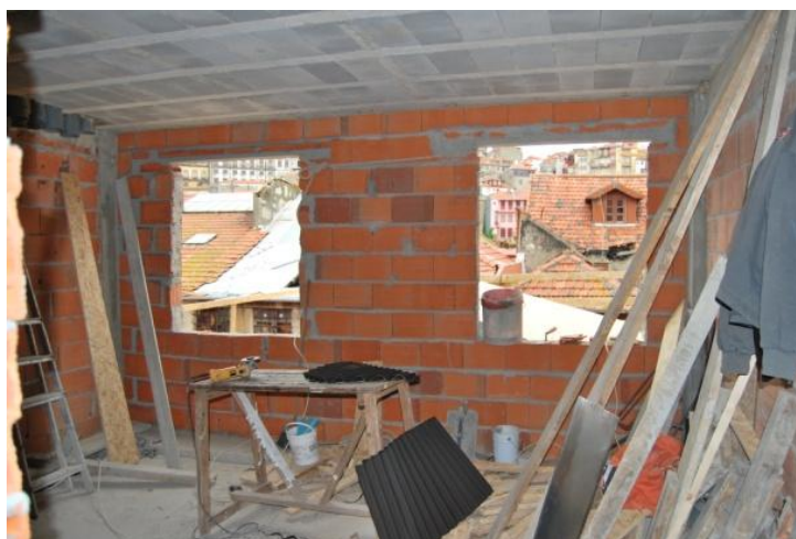
Figura 85 - Parede exterior do 4º Piso [20]
