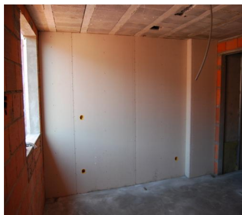
Figura 118 - Aspeto final de uma parede de meação
