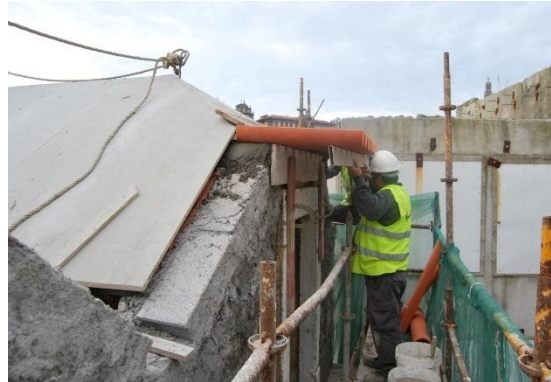
Figura 68 - Colocação da telha lusa [17]
