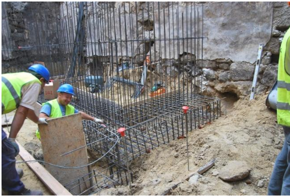
Figura 38 - Colocação armadura e cofragem – sapatas [14]
