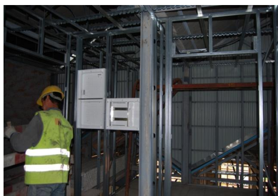
Figura 66 - Instalação do quadro elétrico [17]
