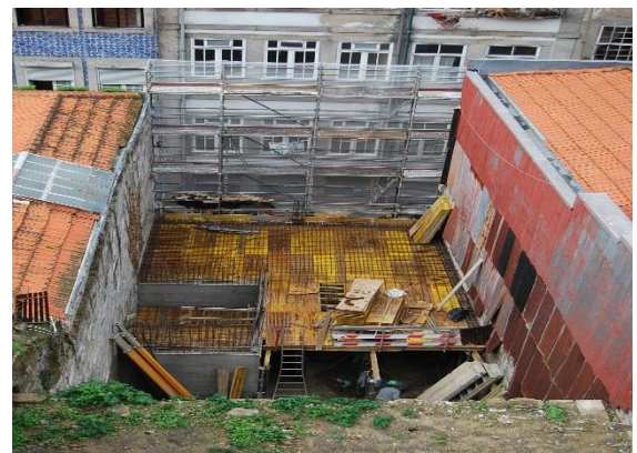
Figura 42 - Execução de laje (Piso 2) [14]
