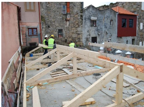
Figura 93 - Execução da cobertura
