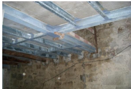
Figura 60 - Apoio das vigas metálicas nas paredes de pedra existentes
