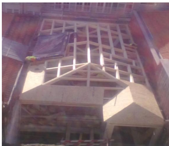
Figura 48 - Colocação das placas de OSB na cobertura
