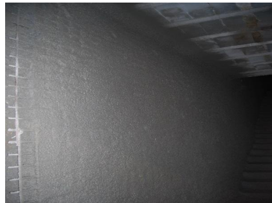
Figura 84 - Aplicação de betão projetado nas paredes [20]
