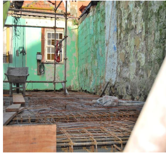
Figura 79 - Execução da laje aligeirada do 1º piso [20]
