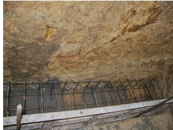
Figura 77 - Cofragem de sapata [20]
