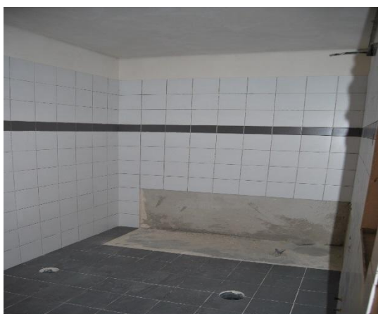
Figura 55 - Aplicação de azulejos em WC [14]
