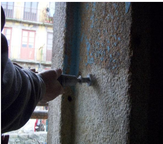
Figura 71 - Limpeza da parede existente em granito
