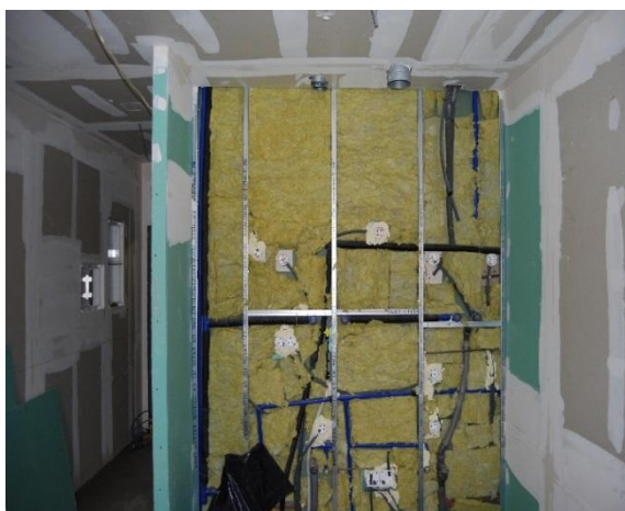
Figura 87 - Instalação das tubagens
