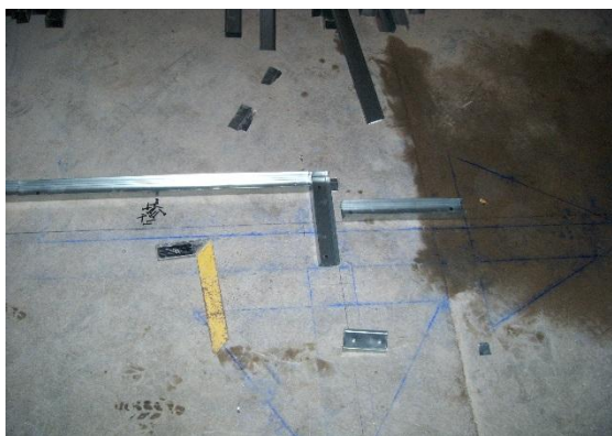
Figura 61 - Marcação da localização das paredes interiores
