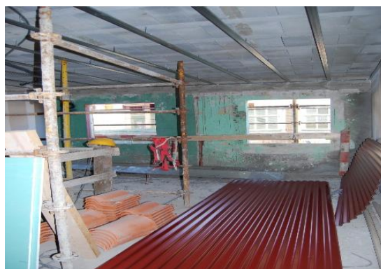
Figura 111 - Materiais armazenados no interior da parcela
