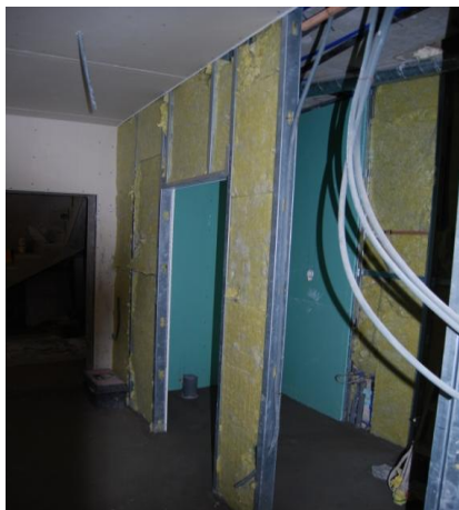
Figura 112 - Lã mineral no interior das paredes divisórias
