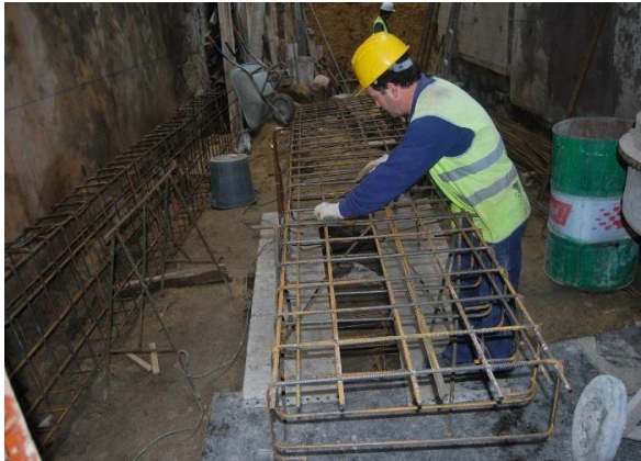
Figura 76 - Montagem de armadura [20]
