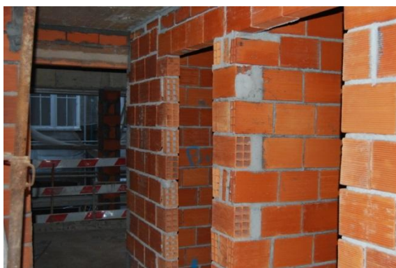
Figura 52 - Paredes divisórias de alvenaria
