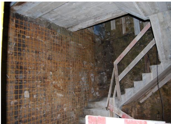
Figura 83 - Escadas de acesso às habitações
