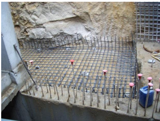
Figura 45 - Colocação de armadura - logradouro
