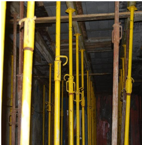
Figura 80 - Escoramento da laje aligeirada do 1º piso
