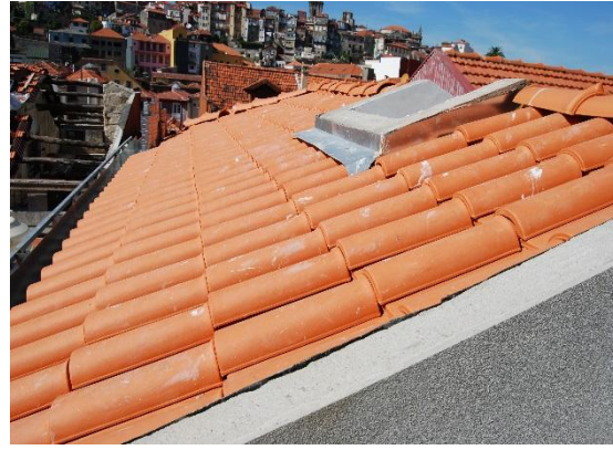
Figura 96 - Colocação da telha
