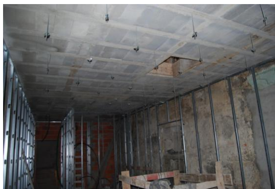
Figura 114 - Colocação dos varões de suporte do teto falso
