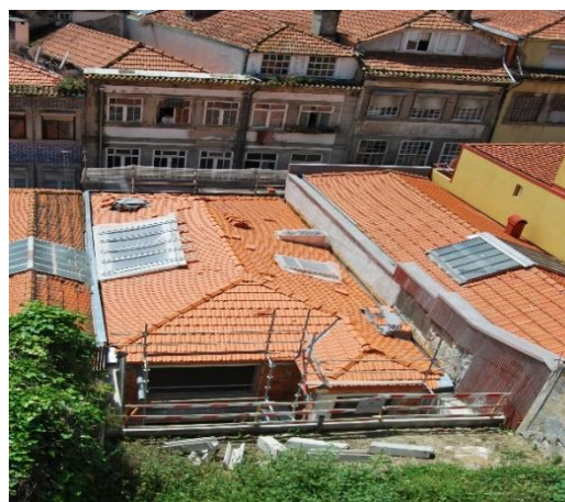
Figura 51 - Cobertura com telha lusa
