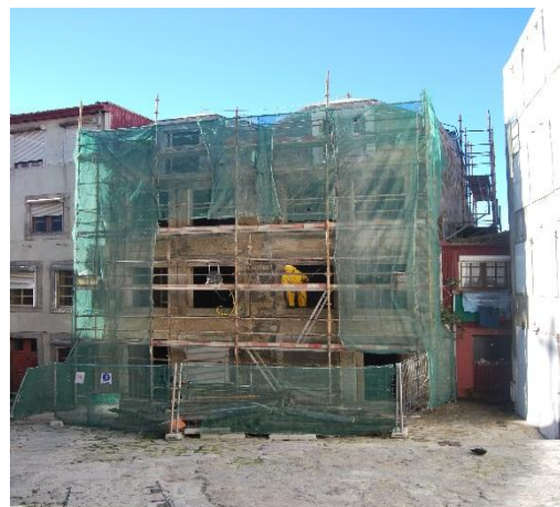
Figura 72 - Limpeza das paredes exteriores [17]
