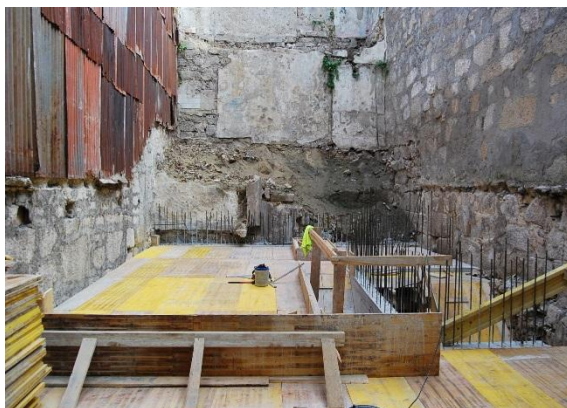
Figura 41 - Execução de laje (Piso 1) [14]
