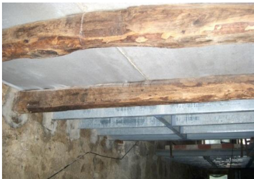
Figura 59 - Aproveitamento dos barrotes de madeira já existentes
