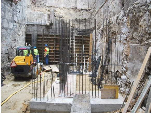
Figura 43 - Cofragem de muro de suporte [14]
