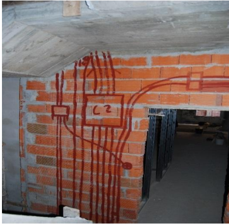
Figura 88 - Marcação de abertura de roços
