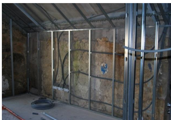
Figura 65 - Instalação das tubagens [17]
