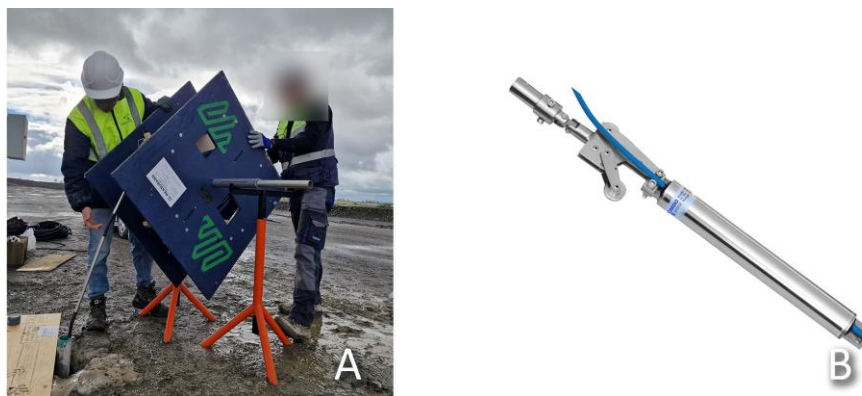
Figura 8 – (A) Instalação de inclinómetro vertical de aquisição automática SAAV (fotografia do autor); (B) Sensor geotécnico representativo dos inclinómetros in-place (Encardio, 2023a)
