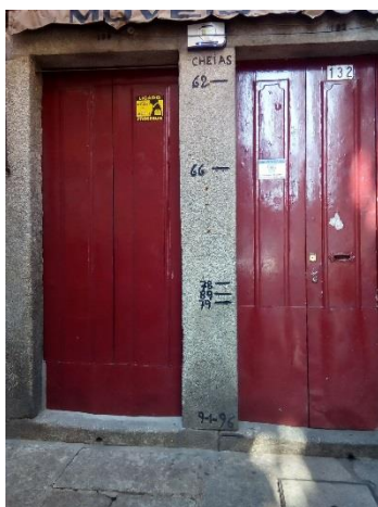
Figura 31: Registo fotográfico das marcas das cheias na ribeira do Porto
