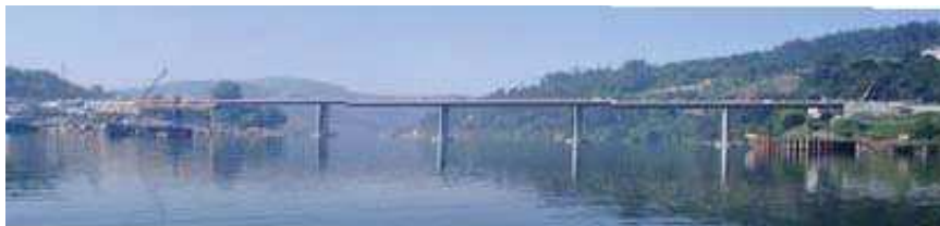
Figura 5 Panorâmica da nova ponte Hintze-Ribeiro
