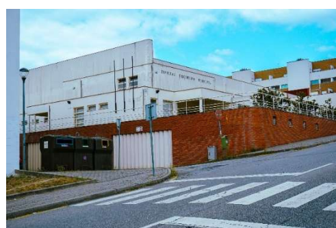
Figura A6 – Pavilhão Desportivo Municipal de Amarante
