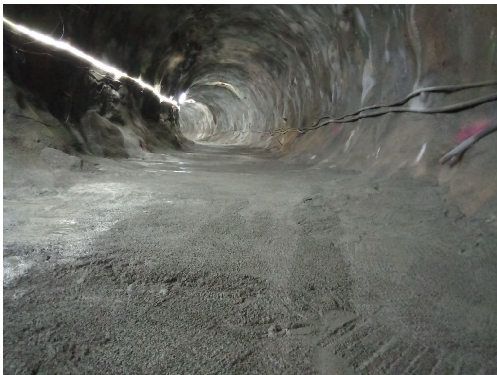
Figura 41 - Superfície regularizada na soleira do túnel.
