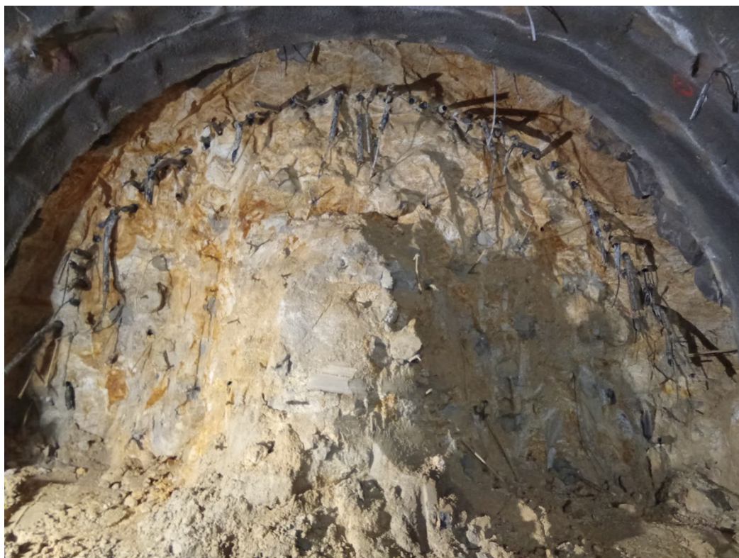
Figura 28 - Frente de escavação. Observam-se enfilagens tubulares como tipo de tratamento (secção do vazio).
