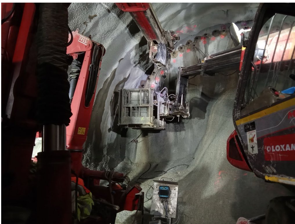
Figura 34 – Execução de injeção de recompressão (IRS) das enfilagens tubulares (tubo Schedule 40 Ø88,9).
