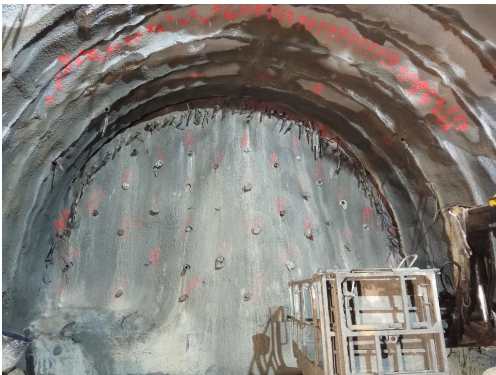
Figura 36 - Frente de escavação com a face de escavação e cambota projetadas onde se identificam as colunas de jet grouting com aplicação de varão de fibra de vidro, tratamento da abóbada com recurso a enfilagens autoperfurantes e geodrenos.
