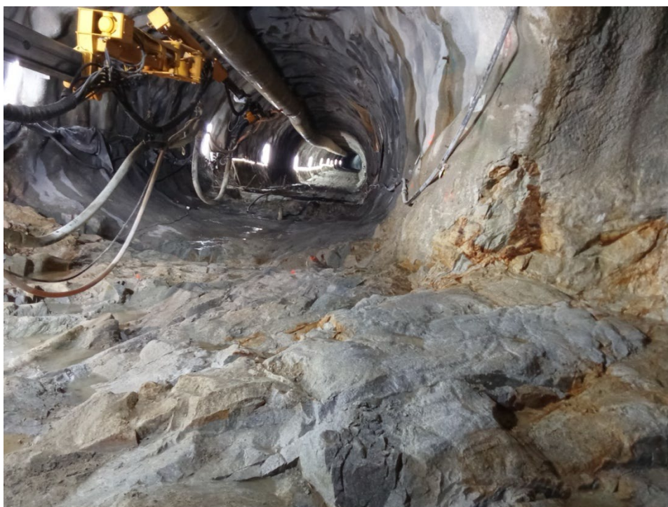
Figura 39 - Soleira do túnel após limpeza e verificação topográfica intermédia. Vista da soleira do túnel após remoção da via provisória e escarificação, apresentando-se pronta para projecção de betão de protecção.
