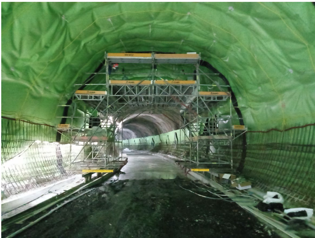
Figura 45 – Carro de aplicação da impermeabilização na abóbada: equipamento móvel sobre carris assentes nos muretes, com plataformas de trabalho; observa-se a armadura dos hasteais a descoberto.
