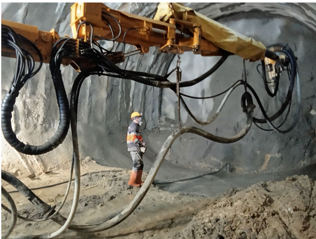
Figura 32 – Execução do arco invertido com operador e equipamento de projecção em operação.
