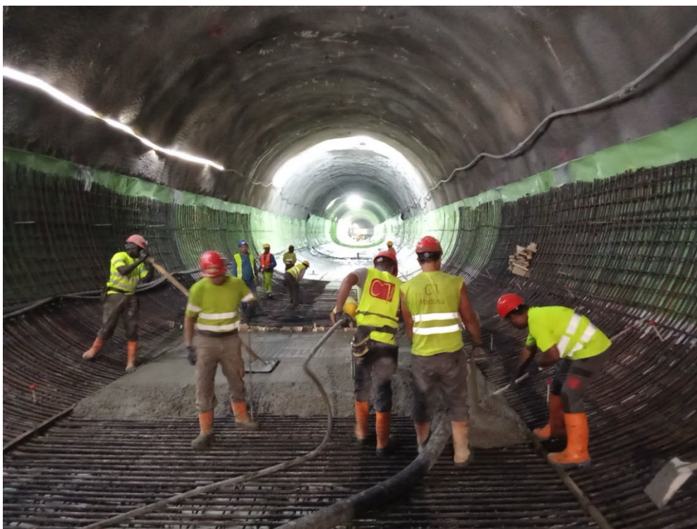
Figura 43 – Betonagem da soleira do revestimento definitivo: aplicação e vibração do betão na camada estrutural sobre a armadura.
