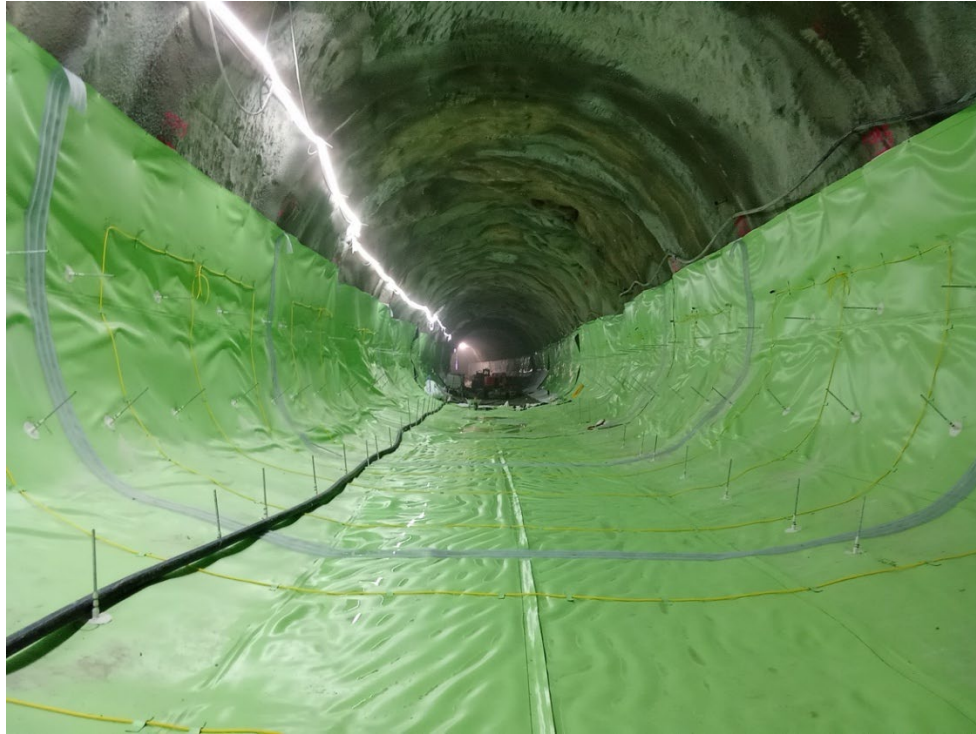
Figura 42 – Vista geral da secção após a instalação da membrana impermeabilizante com protecção de geotêxtil.
