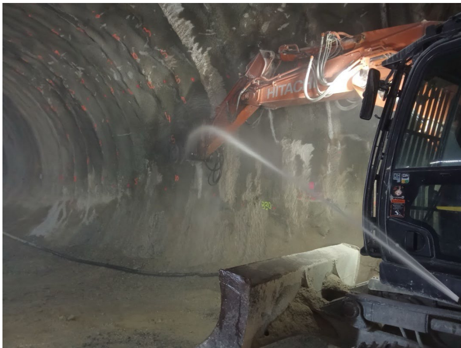
Figura 38 - Escarificação localizada do betão projetado. Operação de fresagem mecânica para remoção de projecção excessiva e correção da geometria da secção escavada, executada após verificação topográfica intermédia.
