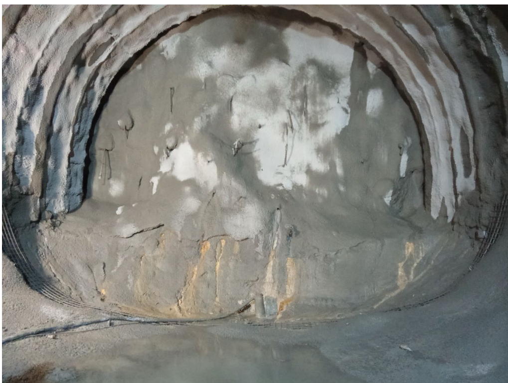
Figura 33 - Vista frontal da secção com o arco invertido, incluindo a malha metálica e o betão projetado.
