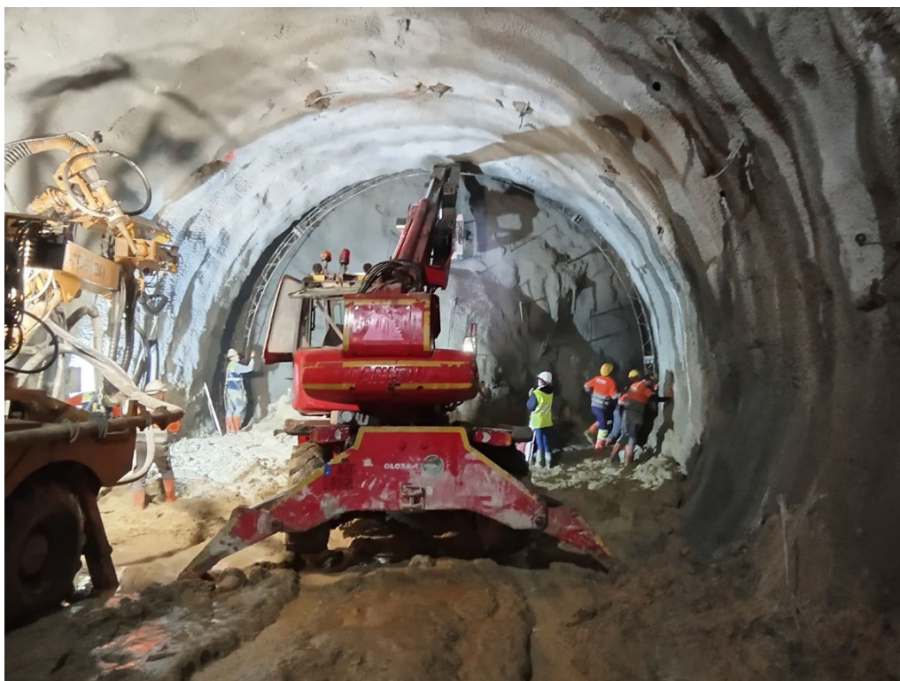
Figura 31 – Instalação de cambota como reforço provisório.
