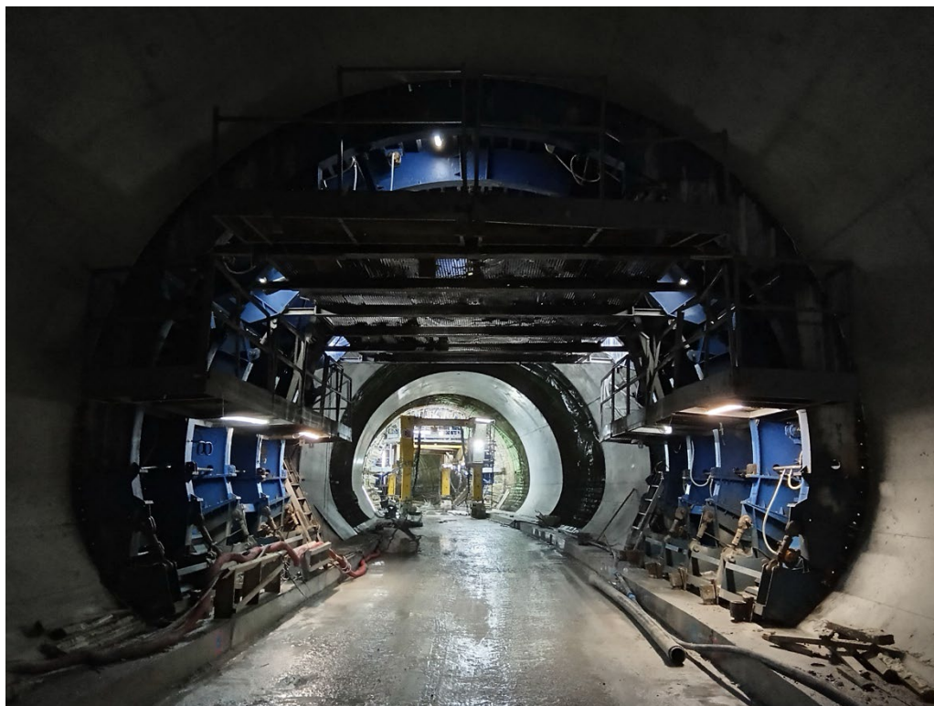
Figura 46 – Carro de cofragem do revestimento definitivo: equipamento metálico modular, apoiado nos muretes, com janelas de inspecção e circuitos de vibração; ao fundo observa-se um troço já betonado.
