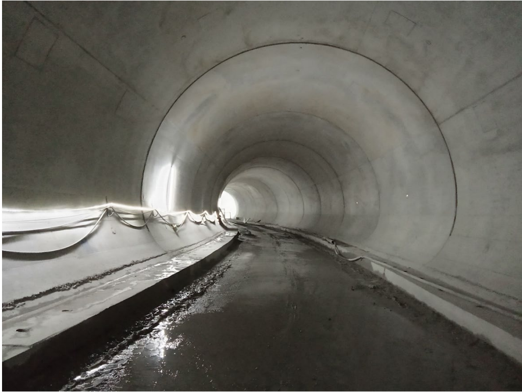
Figura 47 – Aspecto final do túnel após o revestimento definitivo: secção de via dupla concluída, com superfície regular.
