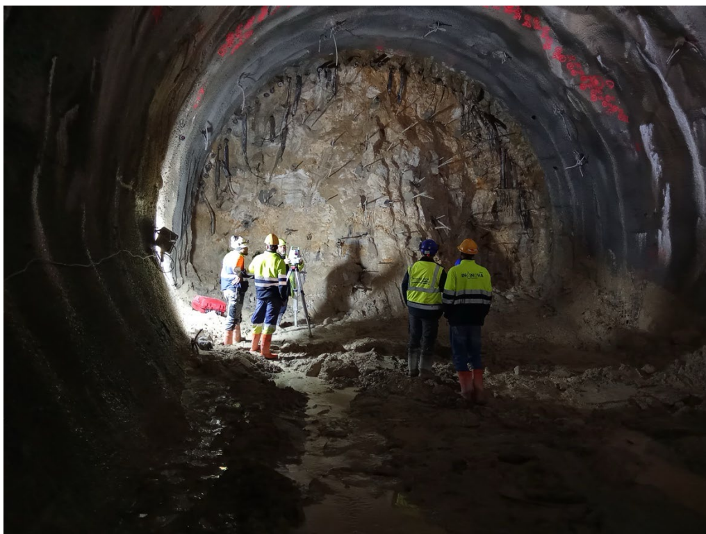
Figura 29 - Preparação da frente escavada antes da aplicação do betão projetado. A fiscalização verifica a geometria e as condições de aplicação do betão.
