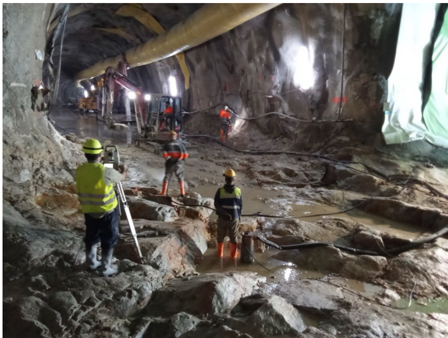
Figura 37 - Picagem pontual de áreas que invadem a secção, limpeza e verificação topográfica intermédia para controlo dimensional da secção.
