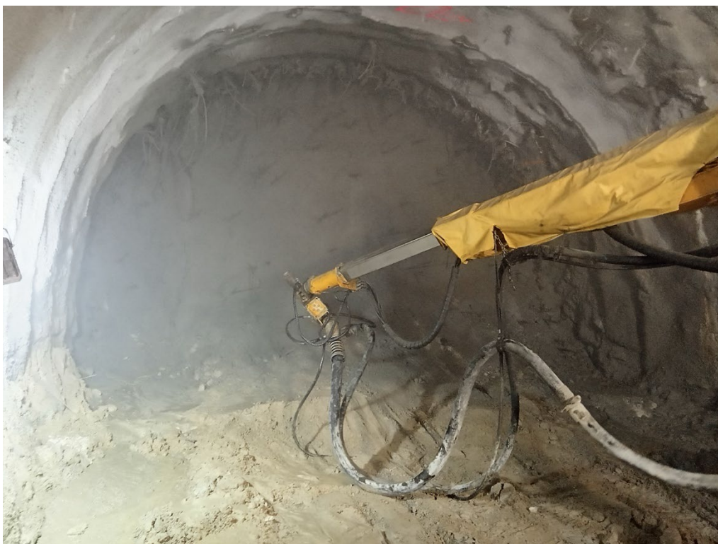
Figura 30 – Aplicação de betão projetado na frente de escavação. Controlo visual da espessura, homogeneidade da superfície e continuidade da projecção.
