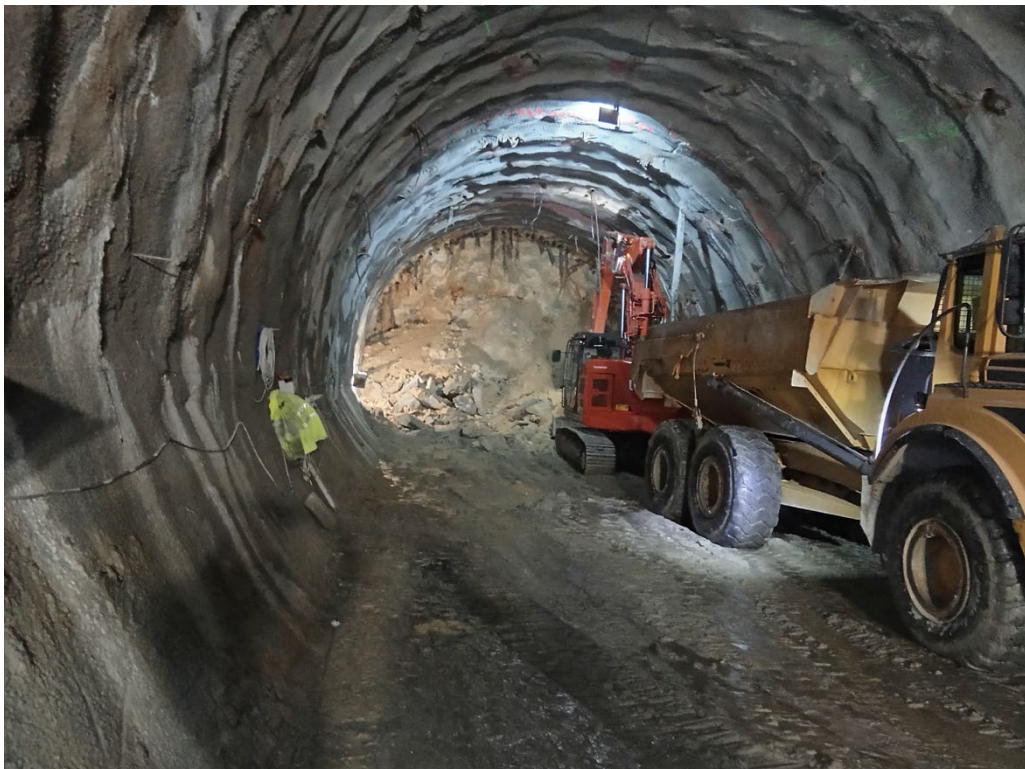
Figura 27 - Avanço da escavação, com remoção do escombro e controlo da frente.
