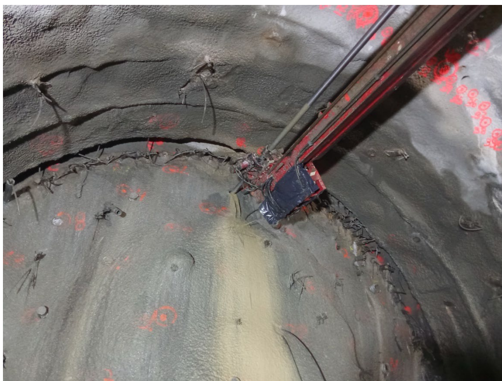
Figura 35 - Execução de coluna de jet grouting com aplicação de varão de fibra de vidro.
