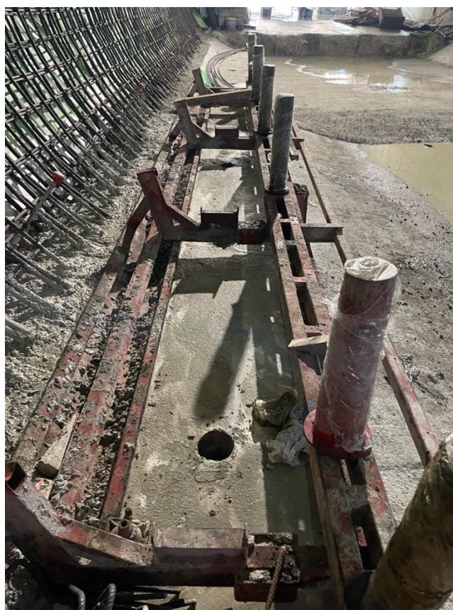
Figura 44 – Execução do murete de arranque para apoio do carro de cofragem. À esquerda, observa-se a armadura dos hasteais e a faixa da membrana impermeabilizante.
