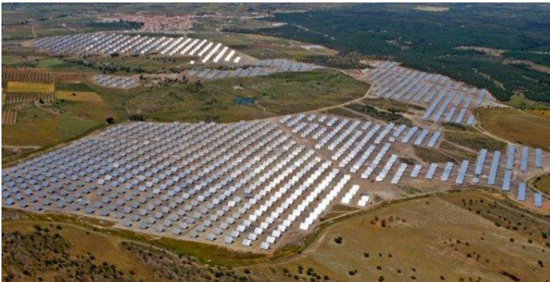
Figura 5 - Central solar da Amareleja no Alentejo (Energia, 2008)
