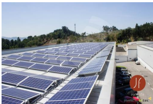
Figura 6 - Instalação solar para autoconsumo (Têxteis J. F. Almeida, 2018)
