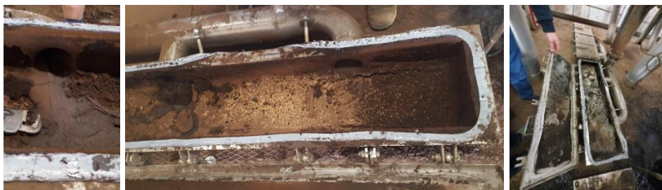
Figura 30- Redes de exaustão colmatadas
