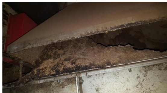
Figura 29- Redes de extração colmatadas
