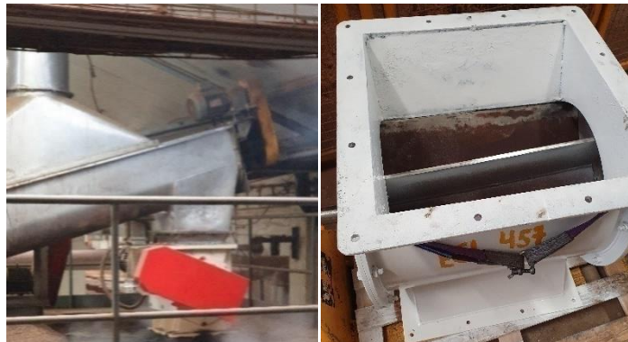
Figura 38- Substituição da eclusa do topo
