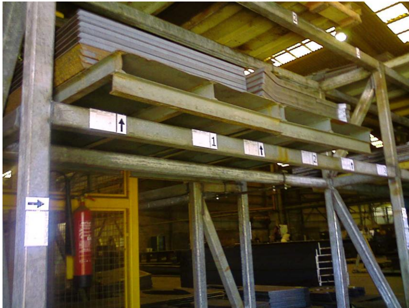
Figura 40 Vista parcial do supermercado de abastecimento da linha PPM
