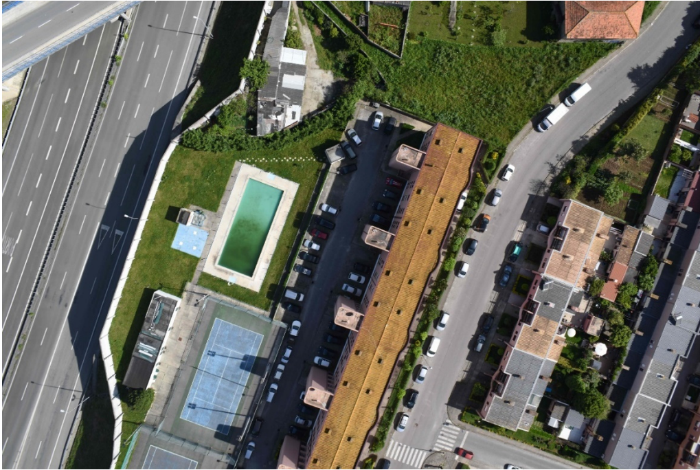
Figura 31 - Fotografia Aérea do muro (Ascendi)
