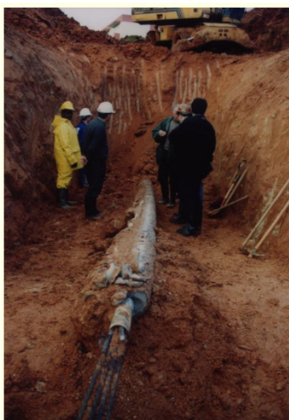
Figura 21 - Escavação do comprimento de selagem da ancoragem (Mariana de Carvalho, 2018)
