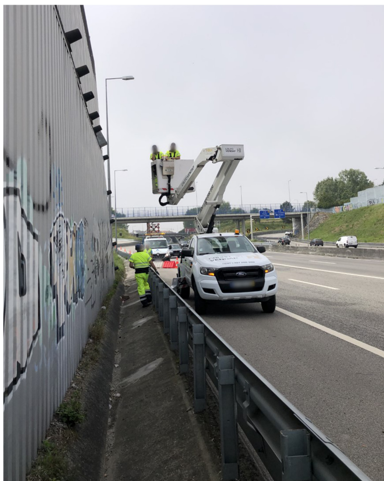
Figura 36 - Preparação da zona e equipamentos de trabalho
