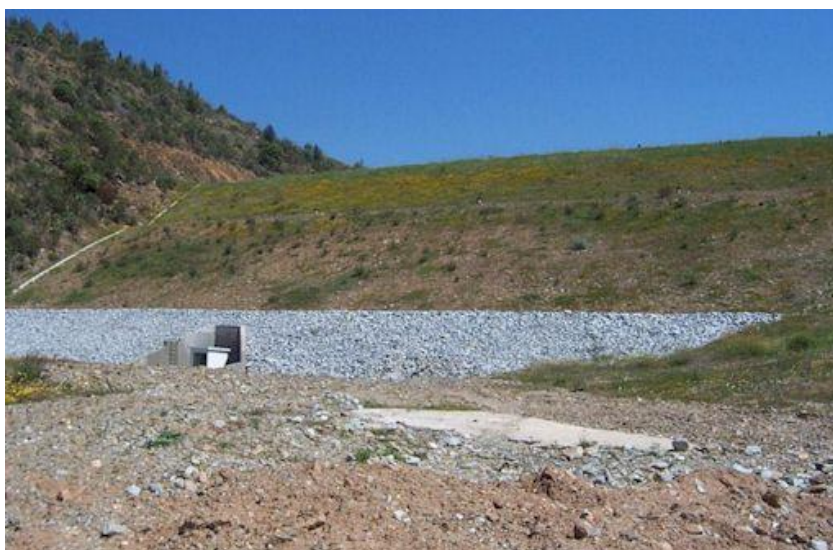
Figura 16 - Barragem do Açafal, vista do talude jusante (Fonte: https://cnpqb.apambiente.pt/content/a%C3%A7afal )
