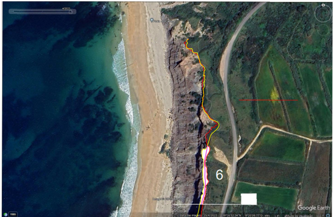
Figura 33 - Imagem de satélite 3 do Caniçal - Talude 6.
