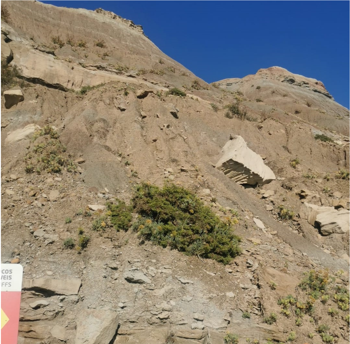
Figura 20 - Alteração da face do talude de Paimogo.
