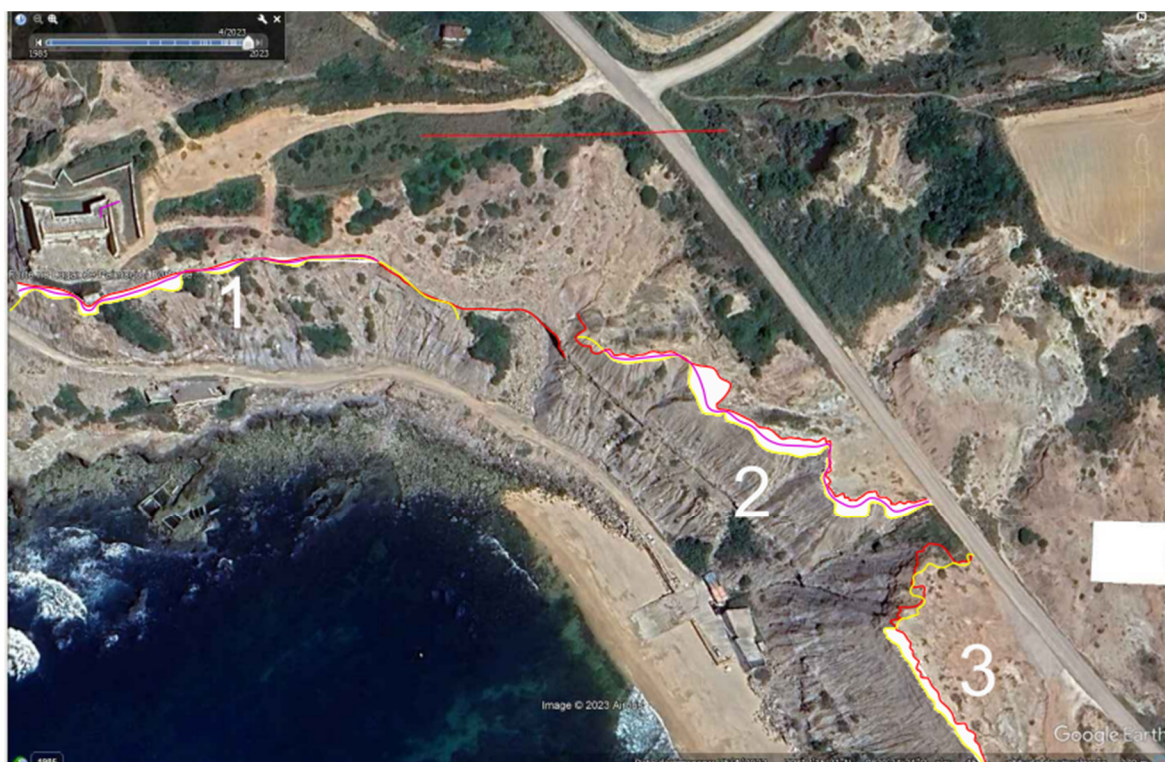
Figura 31 - Imagem de satélite 1 de Paimogo - Talude 1/2/3.
