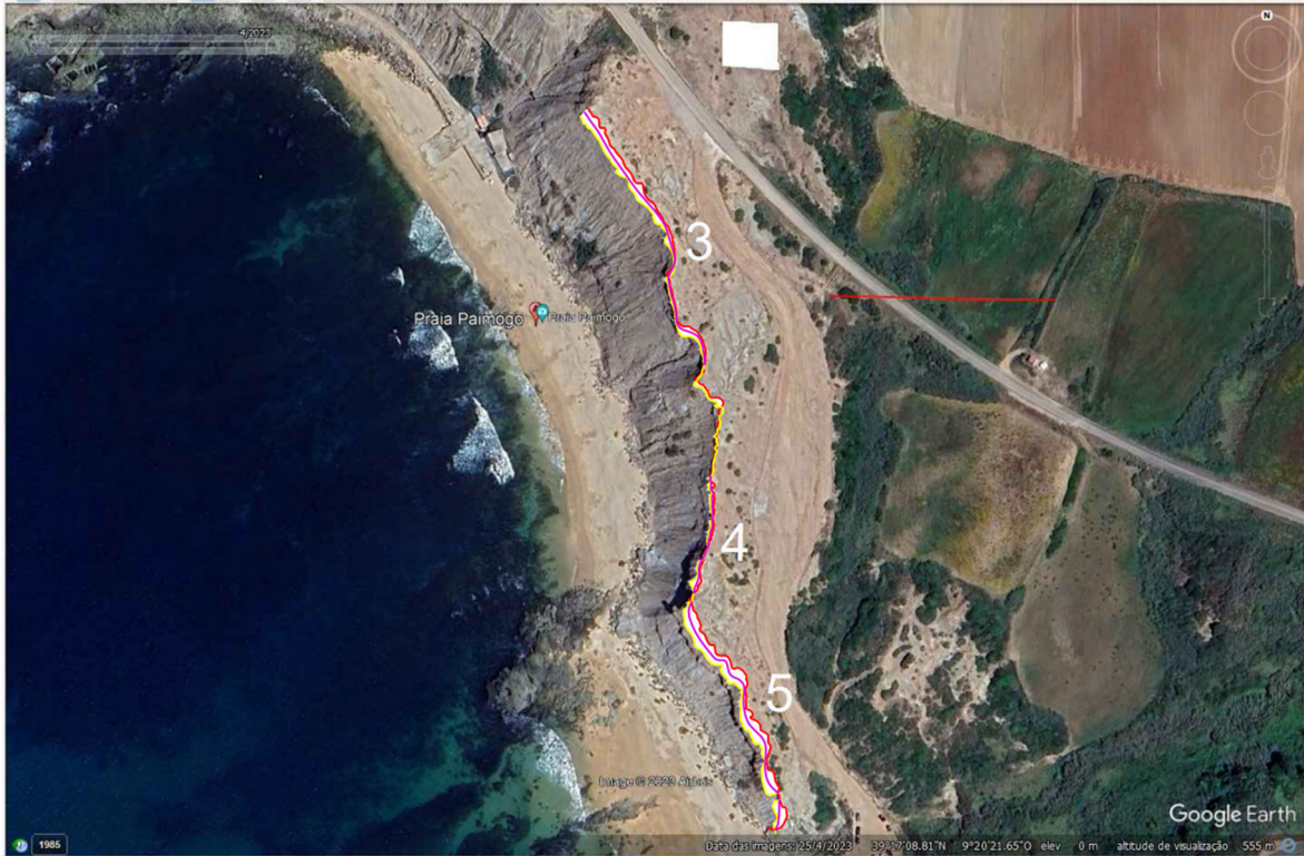
Figura 32 - Imagem de satélite 2 de Paimogo - Talude 3/4/5.
