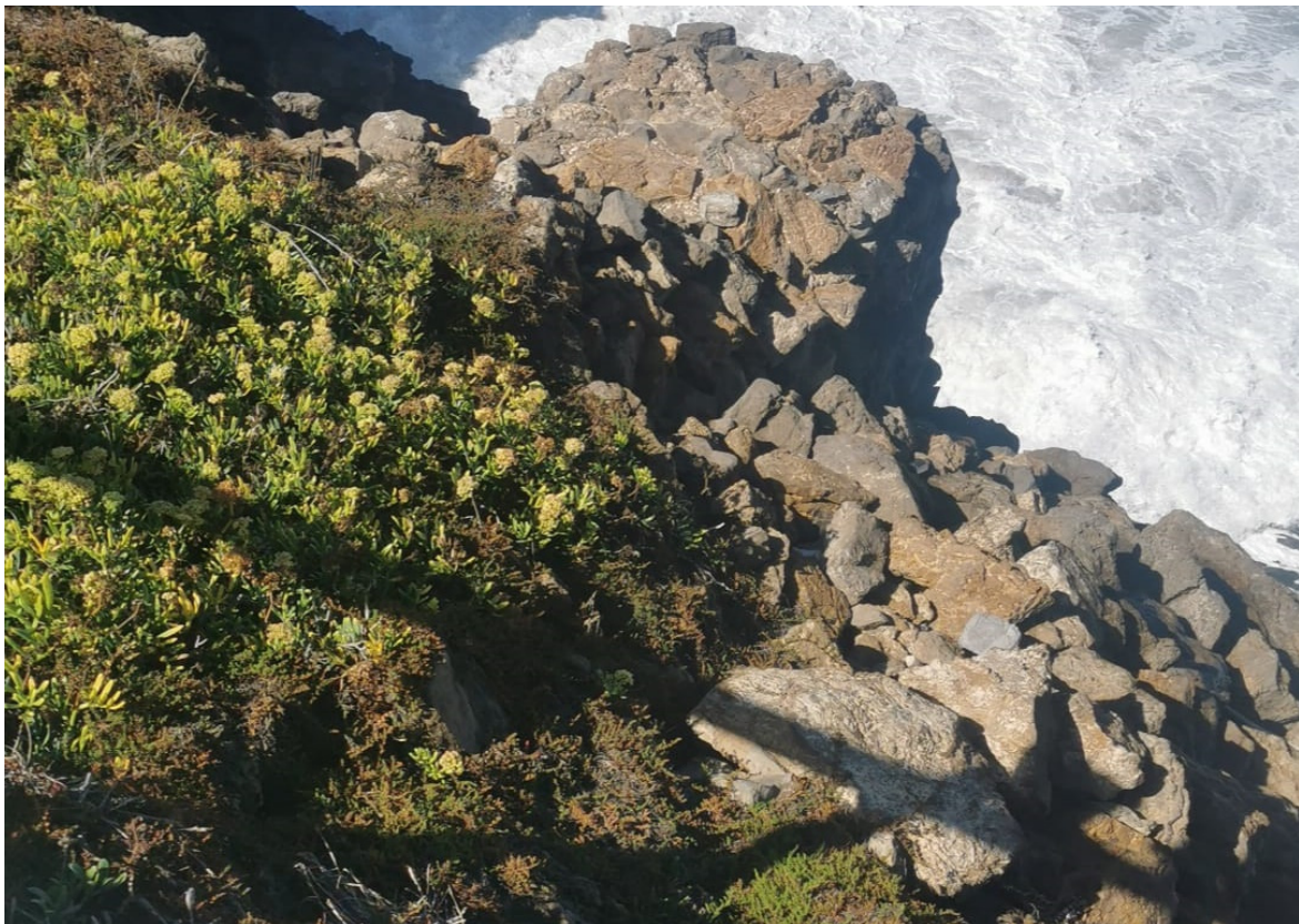
Figura 21 - Intervenção talude 2 de São Pedro de Moel.
