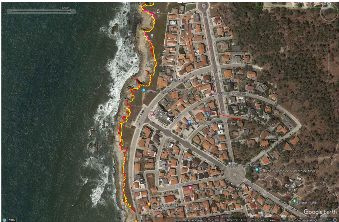
Figura 25 - Imagem de satélite 3 de São Pedro de Moel - Talude 5/6.
