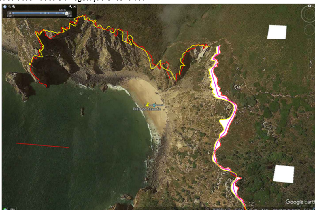
Figura 39 - Imagem de satélite 1 de Assentiz - Talude 1.
