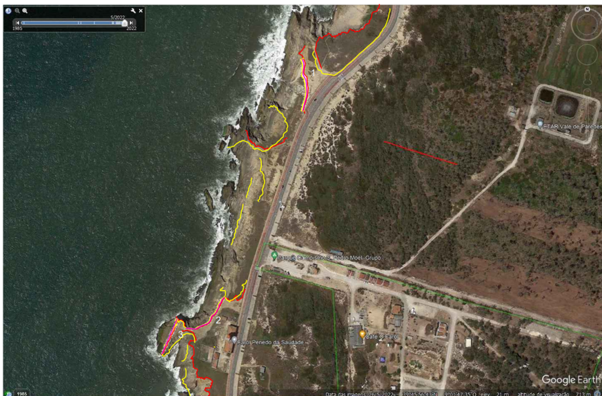
Figura 23 - Imagem de satélite 1 de São Pedro de Moel - Talude 1/2/3.
