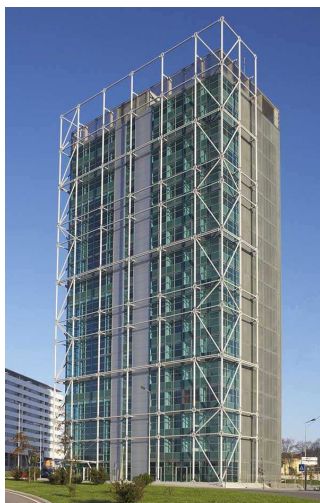
Figura 30 – Fotografia do Edifício
