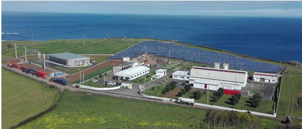
Figura 15 - Solução de armazenamento de energia na ilha Graciosa [46]
