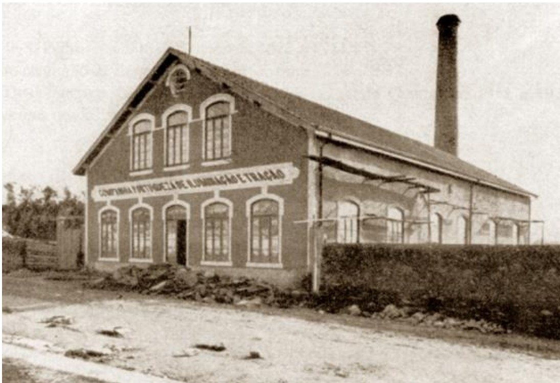
Figura 3 Edifício da Companhia Portuguesa de Iluminação e Tracção de Ovar. [7]
