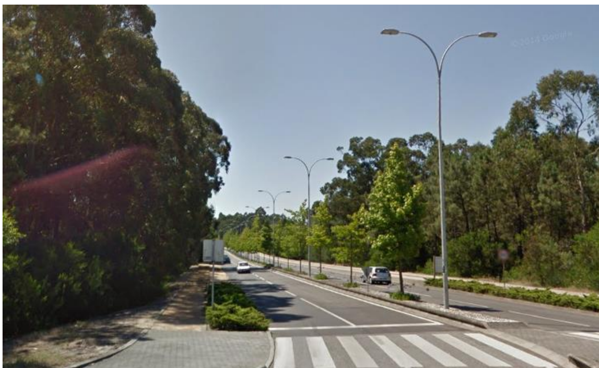
Figura 34 Luminárias Onix de VSAP 150W na Avenida Dr. Francisco Sá Carneiro em Ovar.
