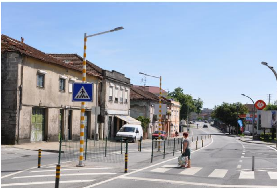
Figura 45 Exemplo de iluminação de passagem de peões. [27]
