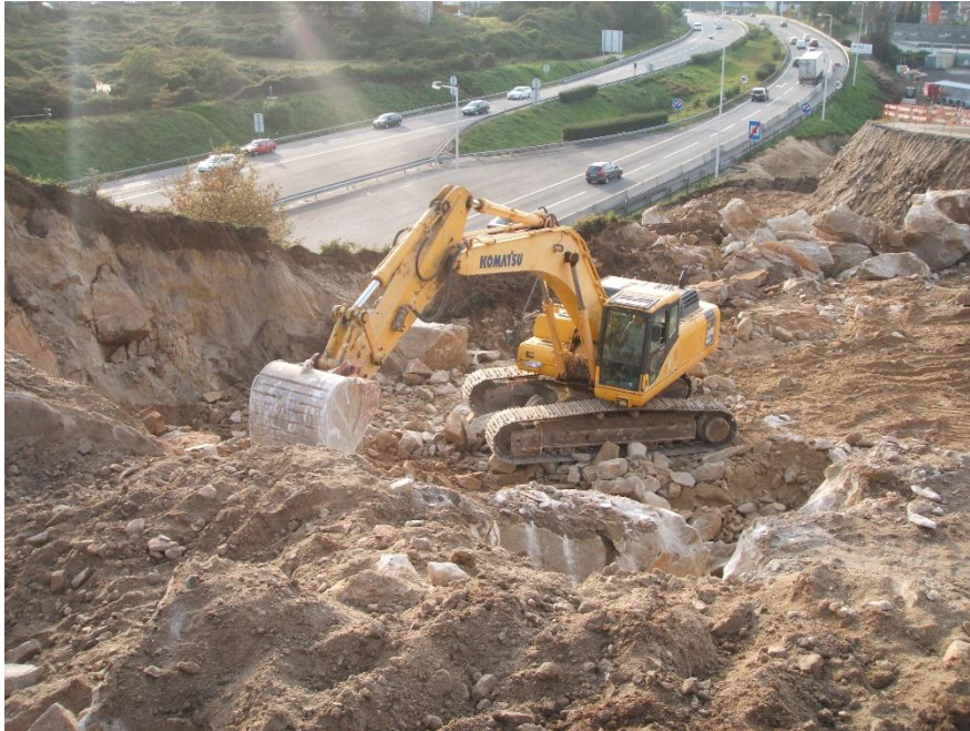
Figura 2 - Trabalhos na obra do Túnel de Águas Santas (Senqual, 2016)
