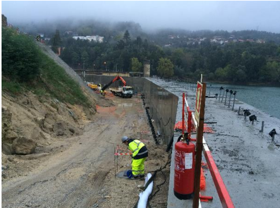
Figura 6 - Construção do Descarregador de cheias Complementar de Caniçada (Senqual, 2016)
