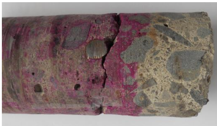
Figura 25 - Fotográfica de ensaio de determinação da zona carbonatada
