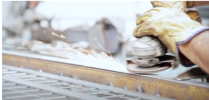
Figura 3.19 - Utilização de uma rebarbadora (Serrialu, 2014)
