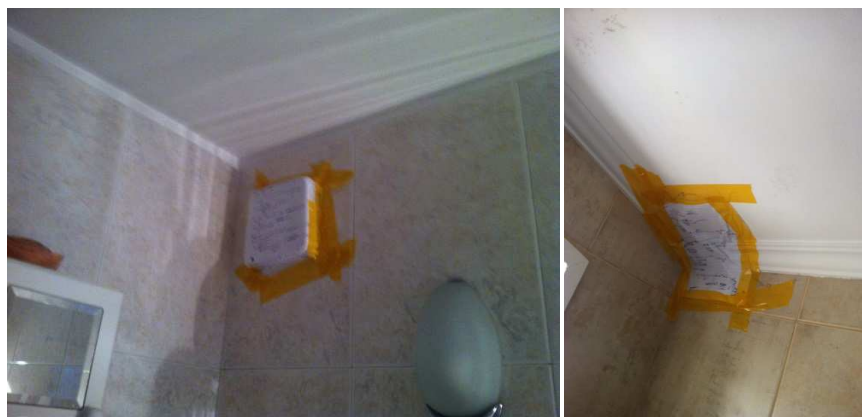
Figura 59 - Conduitas de Exaustão da fracção 3 seladas
