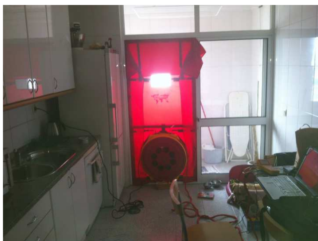
Figura 55 - Instalação da Porta Ventiladora na fracção 2
