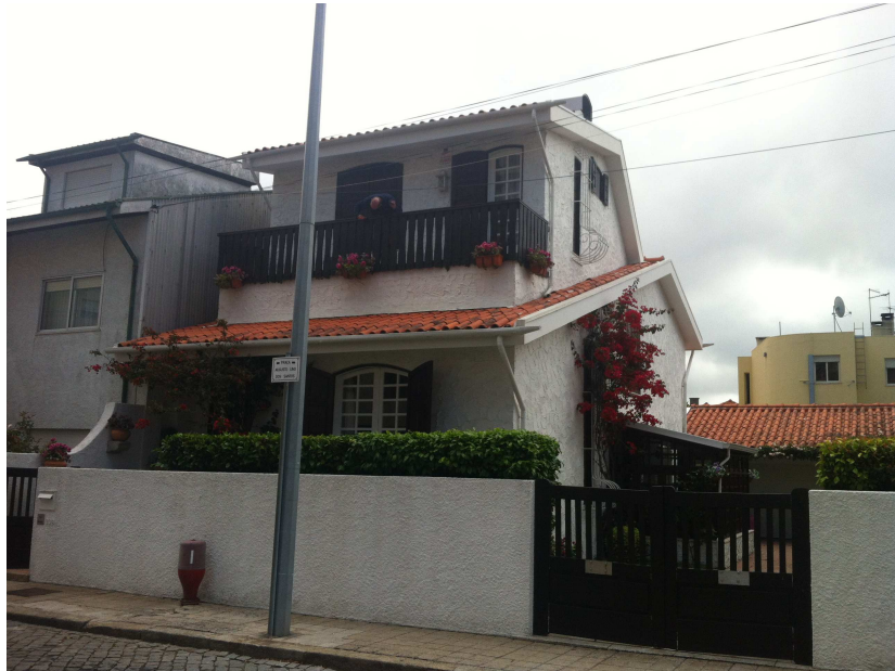
Figura 56 - Caso 3 - Vista Exterior
