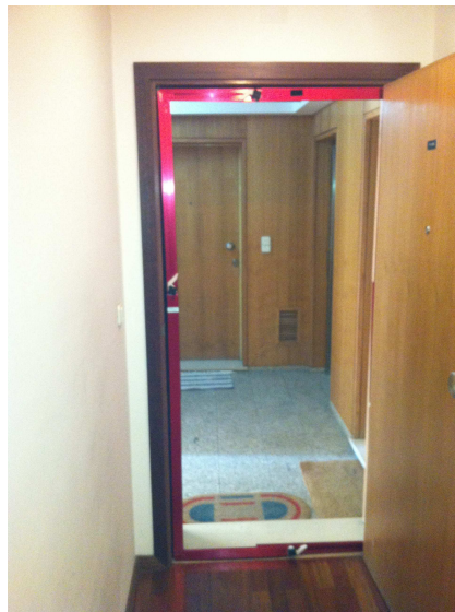
Figura 33 - Montagem e ajuste da caixilharia de alumínio
