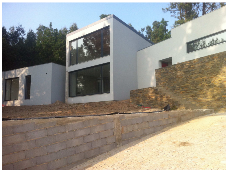
Figura 61 - Caso 4 - Vista Exterior
