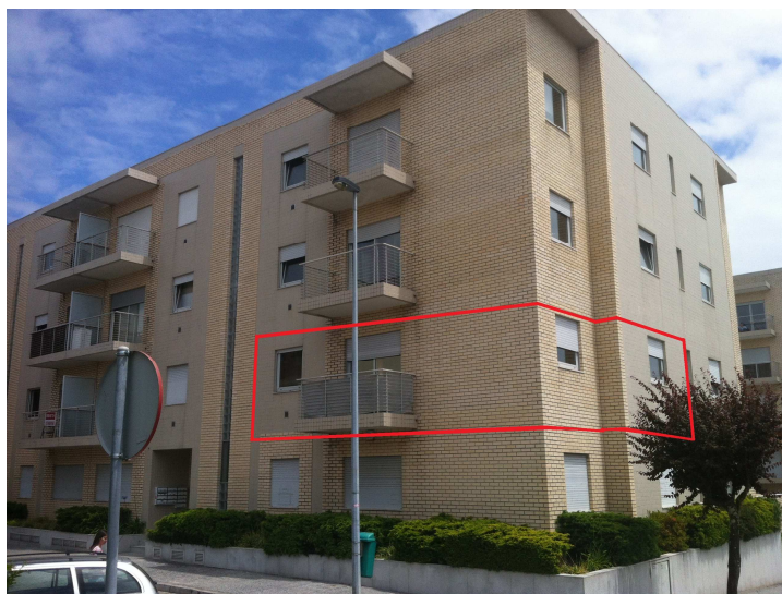
Figura 47 - Caso 1 - Vista Exterior
