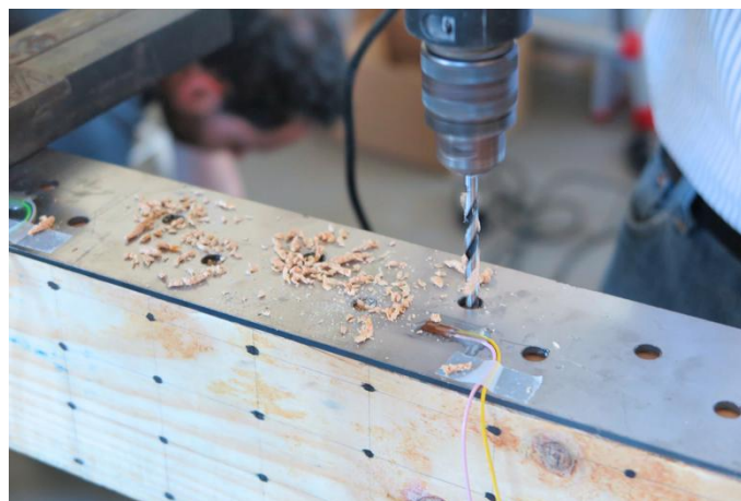
Figura 5.10 – Execução do pré-furo.
