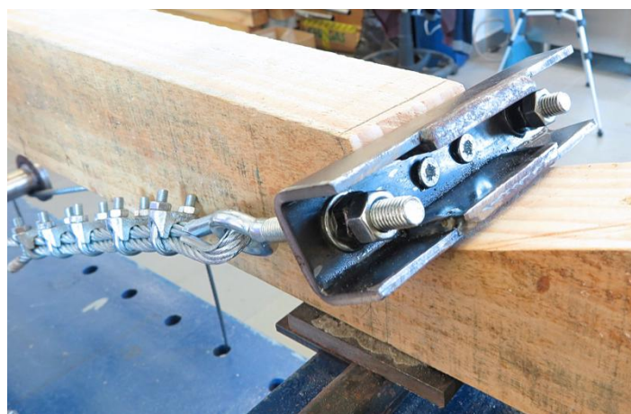
Figura 5.67 – Fim do processo de rosqueamento dos parafusos e pré-esforço dos cabos.
