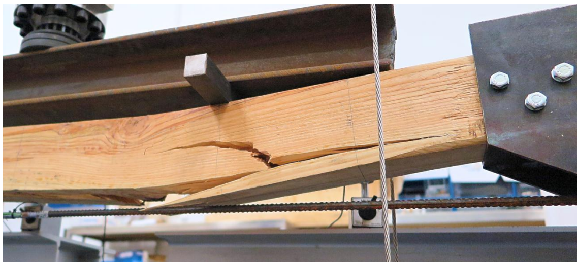
Figura 5.50 – Vista traseira da rotura da viga VV2.
