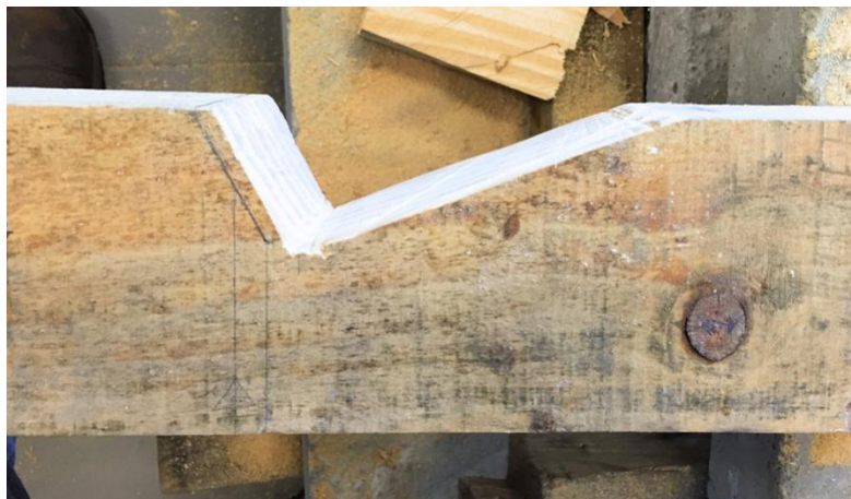
Figura 5.59 – Entalhe executado na madeira para ancoragem do perfil UPN.
