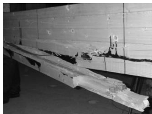
e) Sistema pré-fabricado: Reforço interno
