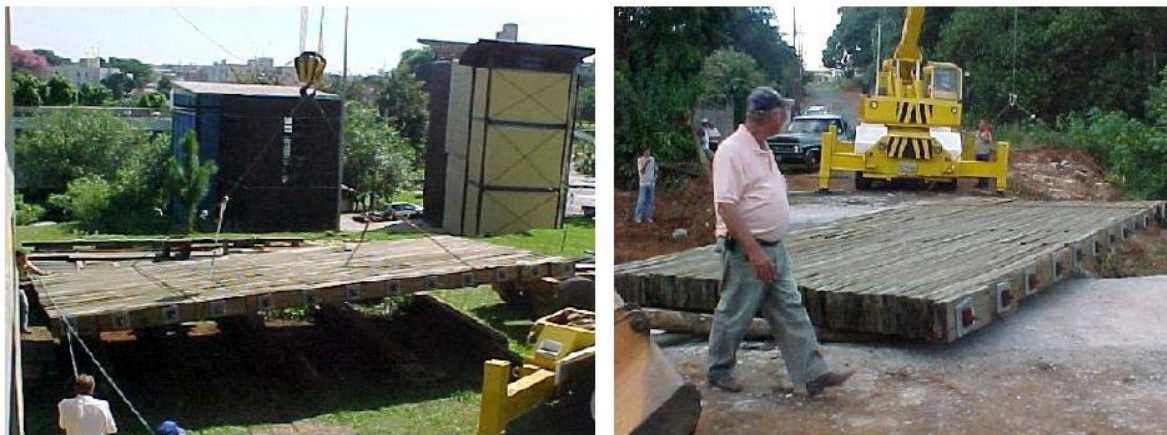
Figura 2.15 – Instalação do tabuleiro da ponte (Fonte e Júnior, 2006).
