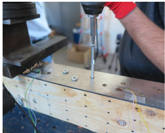
b) Pormenor da instalação do parafuso
