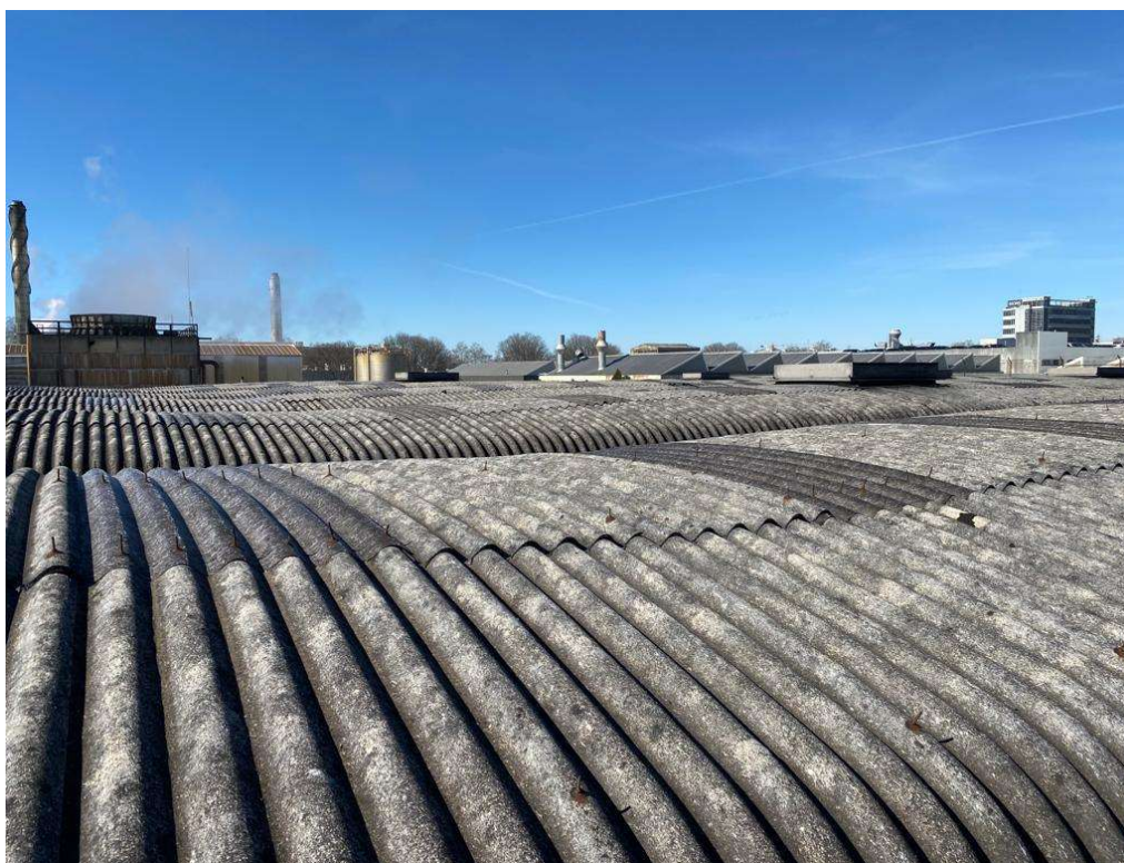
Figura 3.7 – Vista superior 1 do telhado de fibrocimento
