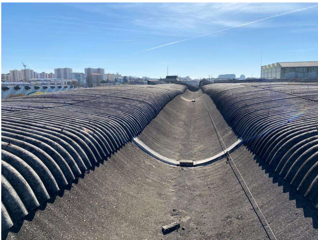
Figura 3.8 - Vista superior 2 do telhado de fibrocimento
