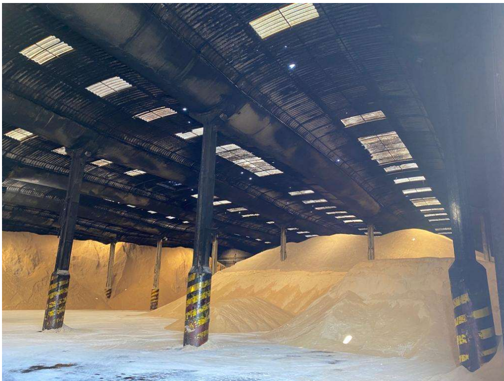
Figura 3.6 - Vista inferior 3 do telhado de fibrocimento
