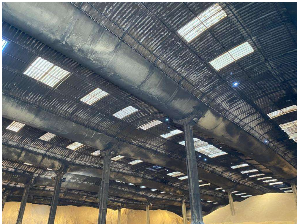
Figura 3.5 - Vista inferior 2 do telhado de fibrocimento
