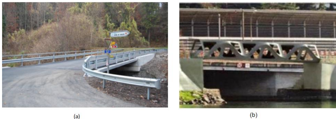
Figura 6- Ponte de trânsito de veículos (a) [21] e ponte pedonal (b) [22]
