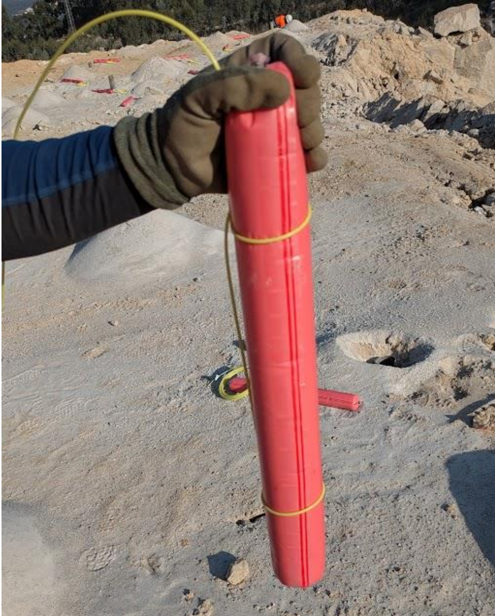
Figura 22– Exemplo de detonador devidamente colocado e atado ao cartucho.
