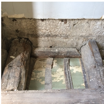
Figura 3.1 – Vigas a serem ensaiadas localizadas numa divisão a Sul do edifício, piso 1.
