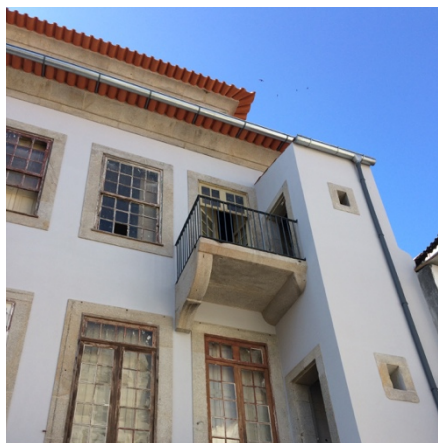
Figura 2.5 – Parede fachada de tardoz.
