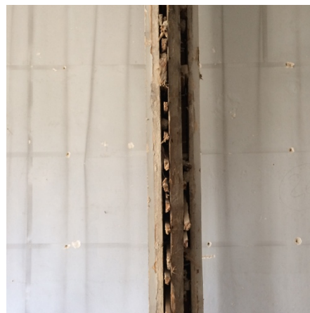
Figura 2.25 – Pormenor de uma parede divisória interior.
