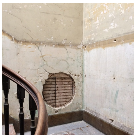
Figura 2.22 – Parede da caixa de escadas.
