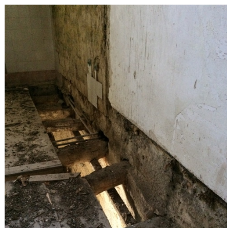
Figura 2.7 – Parede interior em alvenaria de pedra.
