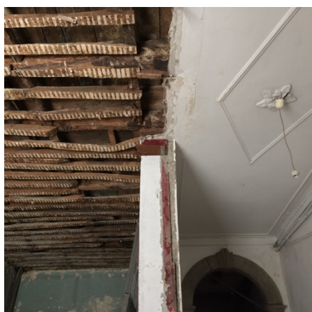
Figura 2.18 – Pormenor do teto fasquiado e parcialmente estucado, no rés-do-chão.
