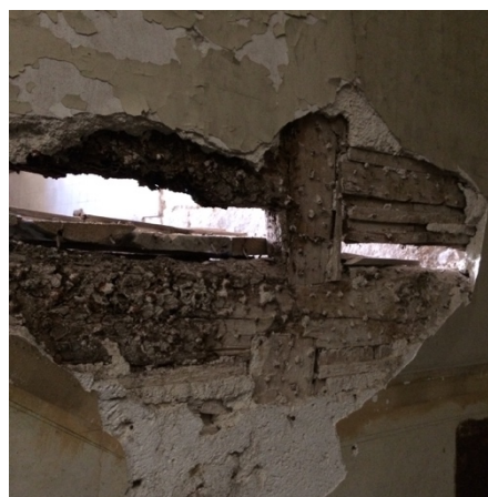
Figura 2.23 – Pormenor de uma parede divisória interior.
