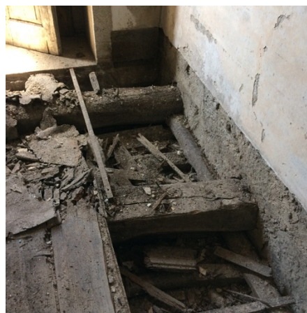
Figura 2.13 – Pormenor de vigas de madeira com as quatro faces falqueadas.
