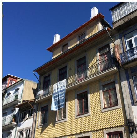
Figura 2.3 – Parede fachada principal.
