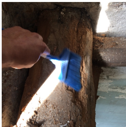
Figura 3.4 – Limpeza da viga para a posterior execução do ensaio.
