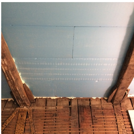
Figura 2.6 – Parede em tabique das águas furtadas.
