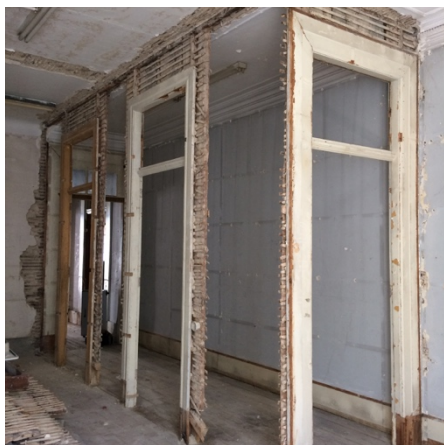
Figura 2.24 – Paredes divisórias interiores desmanteladas.
