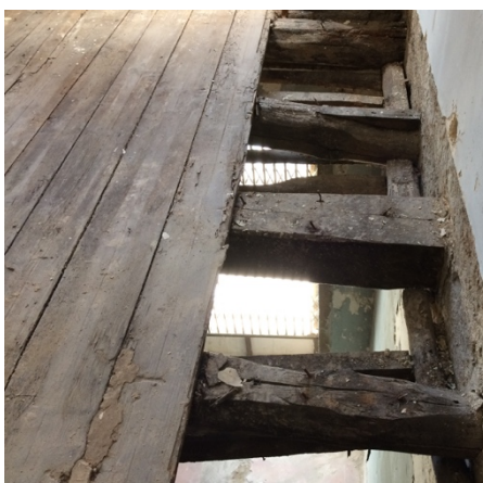
Figura 2.14 – Pormenor do pavimento de madeira.
