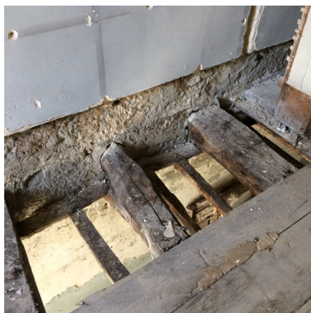
Figura 2.12 – Pormenor de vigas de madeira com as quatro faces falqueadas.
