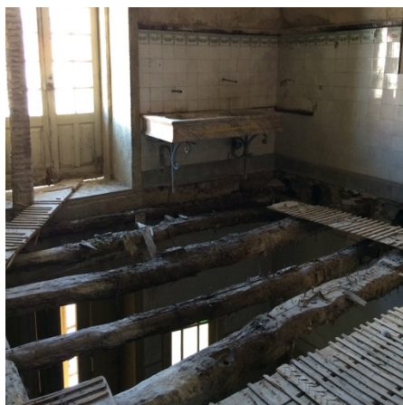
Figura 2.10 – Vigas de madeira de secção circular, constituintes dum pavimento inacessível.
