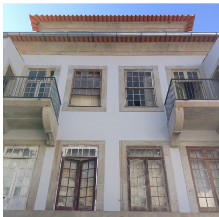
Figura 2.4 – Parede fachada de tardoz.
