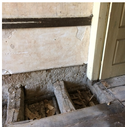
Figura 3.12 – Pormenor da divisão Sul no piso 2.
