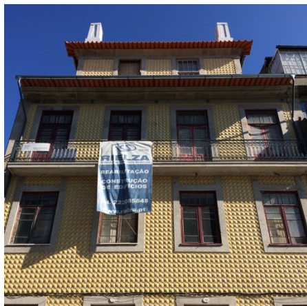
Figura 2.2 – Parede fachada principal.
