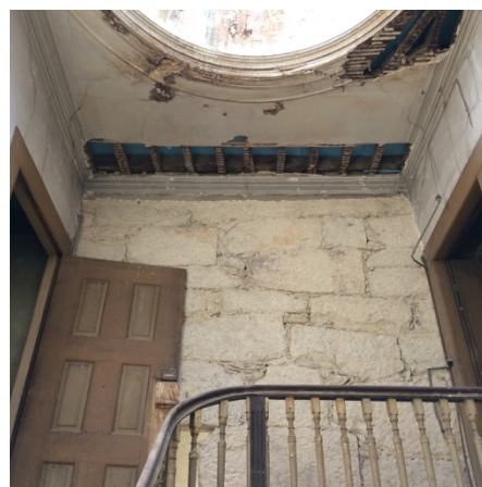
Figura 2.9 – Parede de meação em alvenaria de pedra granítica.
