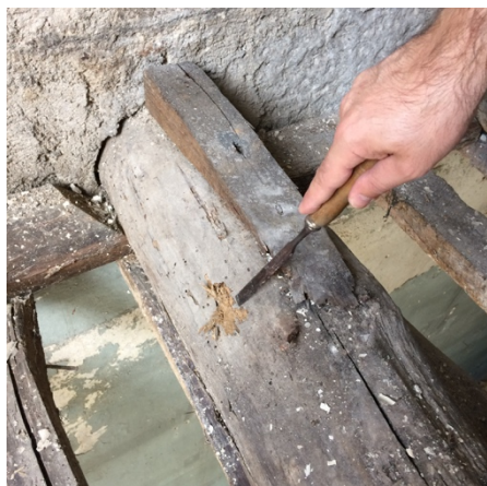
Figura 3.3 – Inspeção e preparação da viga para a realização do ensaio.
