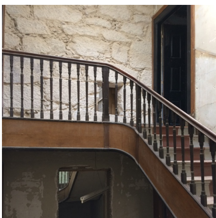
Figura 2.8 – Parede de meação em alvenaria de pedra granítica.
