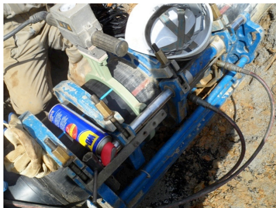
Figura B.7 – Aquecimento das extremidades a soldar.
