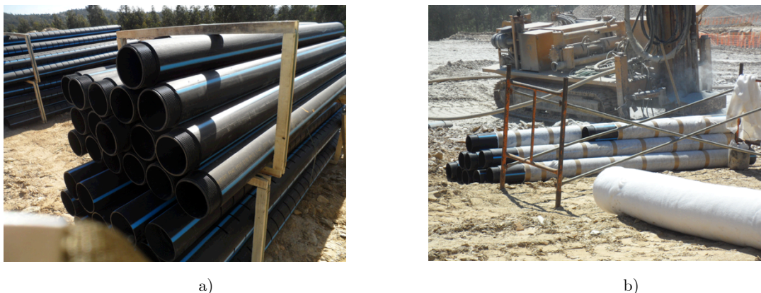
Figura C.6 - Tubagem: a) tubagem PEAD cega (cima) e ranhurada (baixo); b) revestimento de tubagem ranhurada com geotêxtil
