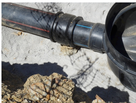
Figura B.16 – Aspeto final da soldadura.
