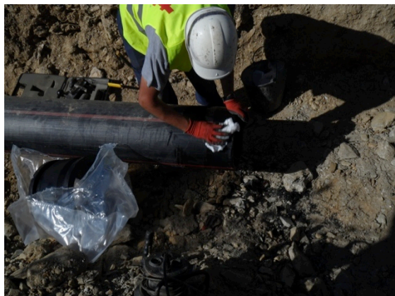
Figura B.13 – Limpeza da superfície.
