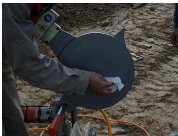
Figura B.6 – Limpeza da superfície da placa de aquecimento
