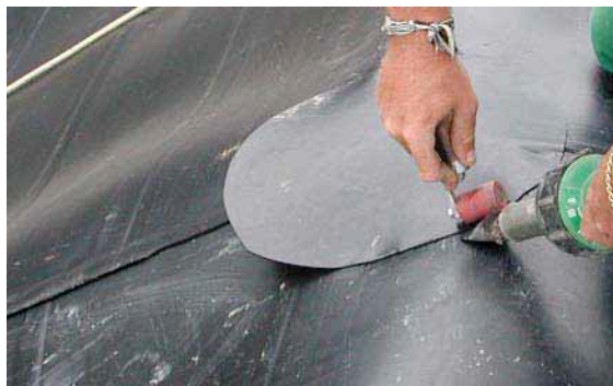
Figura 53 - Exemplo de execução de remendo em geomembranas ( Duarte , 2009).
