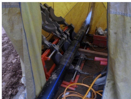
Figura B.1 -Proteção do posto de soldadura por tenda
