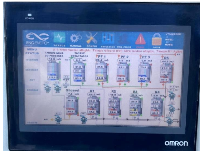
Figura 4.16. Painel do software SCADA
