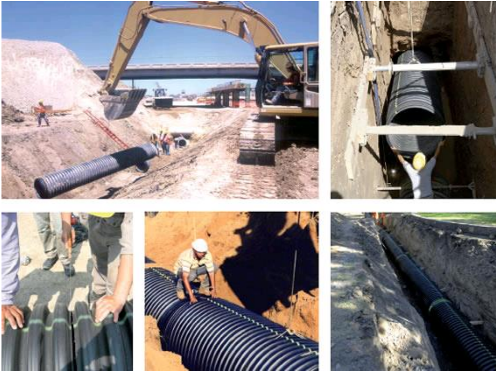
Figura 6 - Abertura de vala para assentamento de conduta
