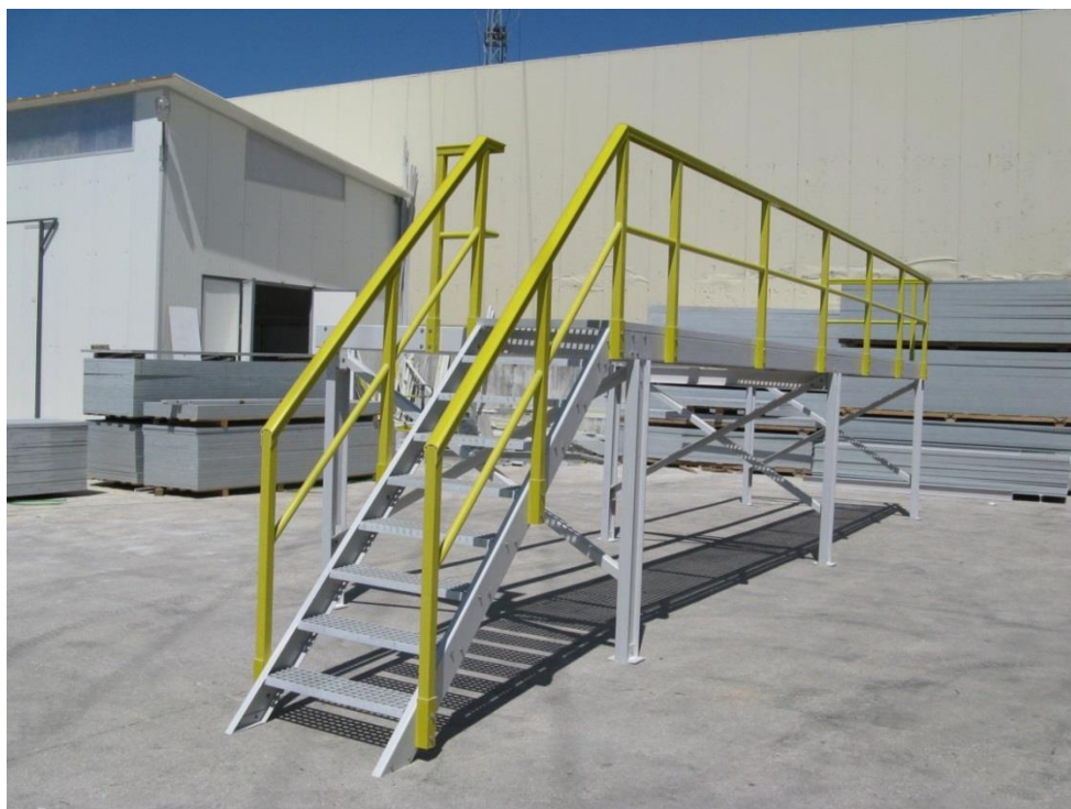
Figura 47 – Pré-montagem da estrutura
