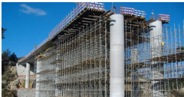
Figura 13 - Cimbra ao solo contínuo [A32 – ponte sobre o rio Insua; Zagope, grupo FCM]
