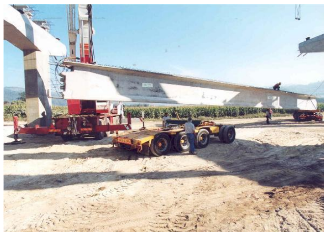
Figura 5 - Elevação de uma viga pré-fabricada; [CIVIBRAL - IC1 Nó da Mealhada]
