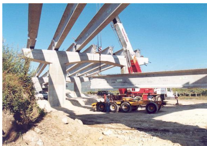
Figura 17 - Colocação das vigas na posição final
