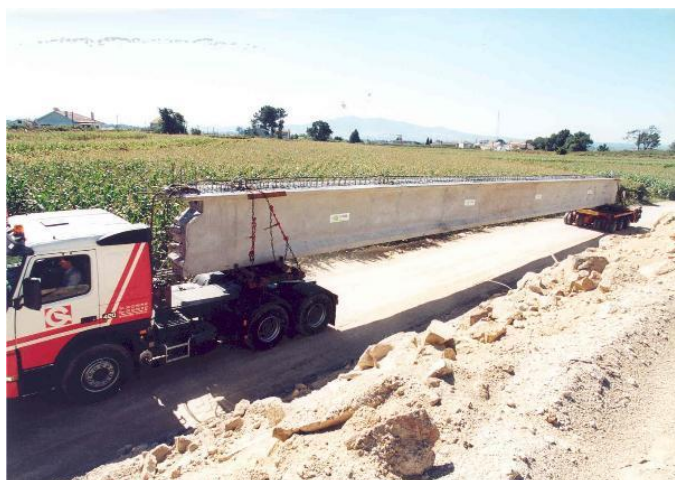
Figura 4 - Transporte especial de uma viga pré-fabricada; [CIVIBRAL - IC1 Nó da Mealhada]
