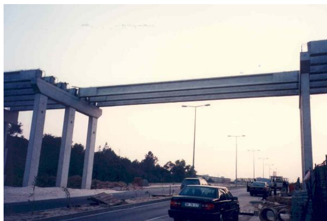
Figura 18 - Posição final das vigas [CIVIBRAL – Ponte Leiria]
