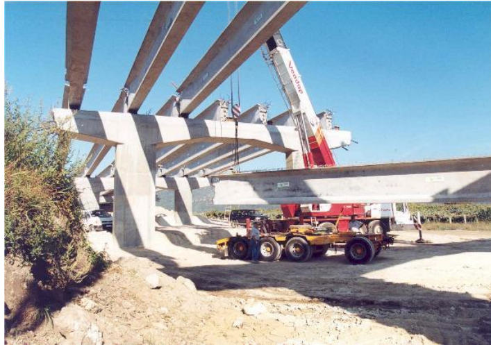
Figura 6 - Elevação e posicionamento de uma viga pré-fabricada na sua posição final; [CIVIBRAL - IC1 Nó da Mealhada]
