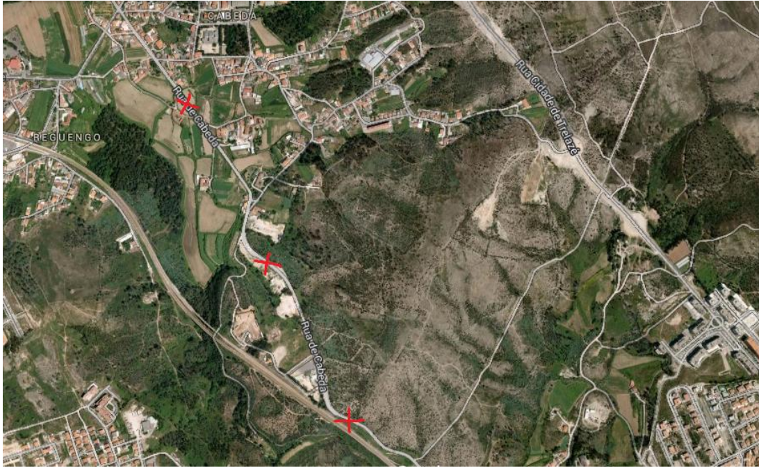
Figura 175 - Localização das Rodeiras Medidas na Rua de Cabeda
