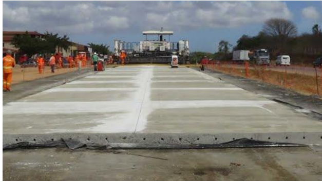
Figura 12 – Execução de um Pavimento Rígido, (Fonte: Panorâmio, 2014)
