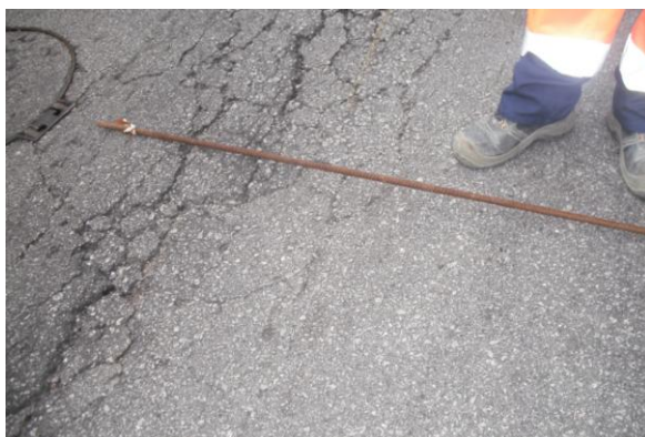
Figura 172 – Varão de Ferro Colocado na Zona da Rodeira
