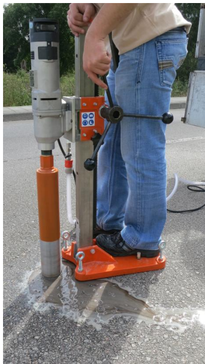
Figura 158 – Perfuração do Pavimento
