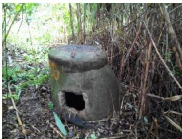
Figura 4.4 - Abertura no corpo de uma câmara de visita do tipo elevada.
