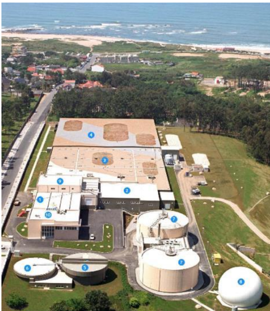
Figura 2.7 - Vista aérea da ETAR de Gaia Litoral (SIMDOURO, 2015).
