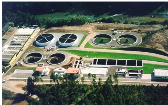
Figura 5.1– Vista aérea da ETAR
