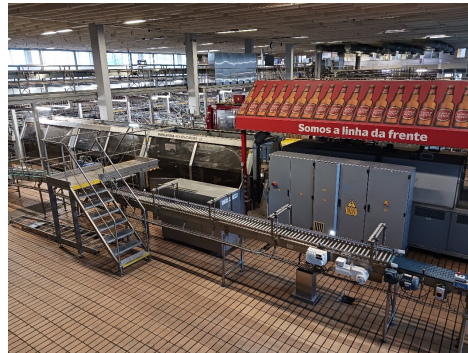
Figura 13 – Aspeto geral do Piso 1 da linha 6
