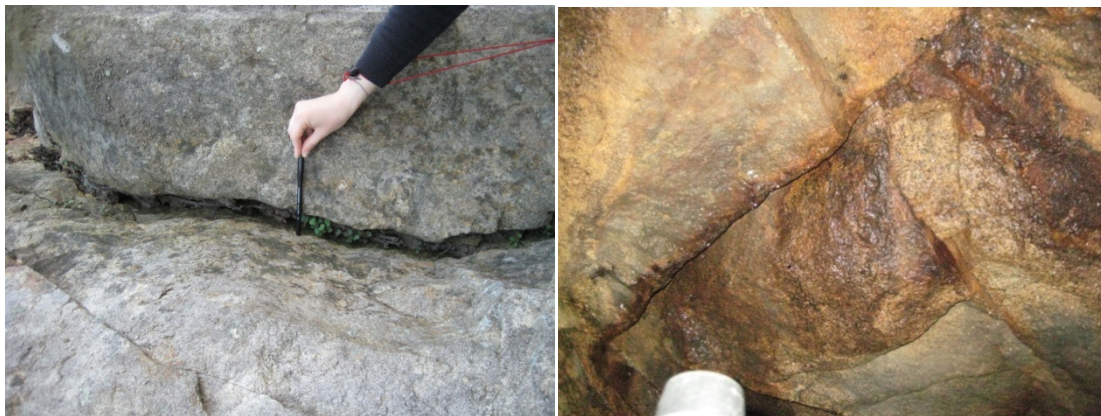
Figura 13. Aspectos da abertura em descontinuidades.
