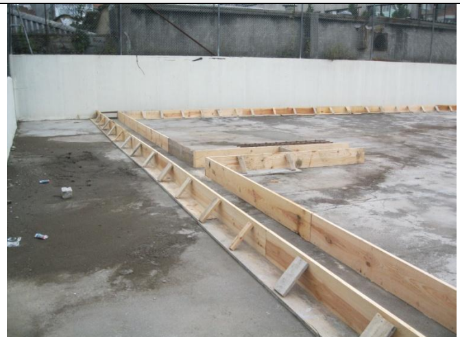
MONTAGEM DA COFRAGEM
