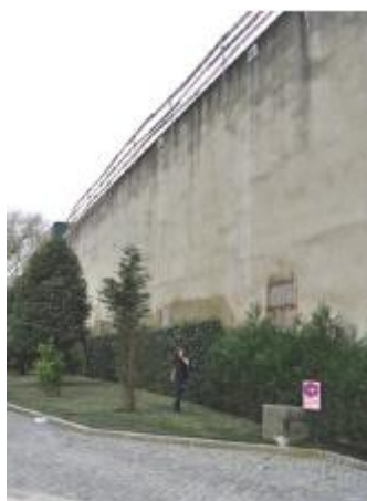
Figura 4 - Fachada Norte do edifício lar
