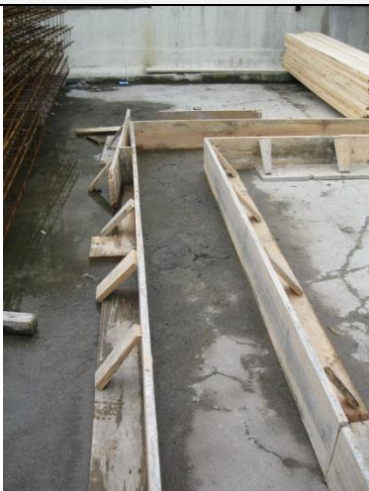
MONTAGEM DA COFRAGEM
