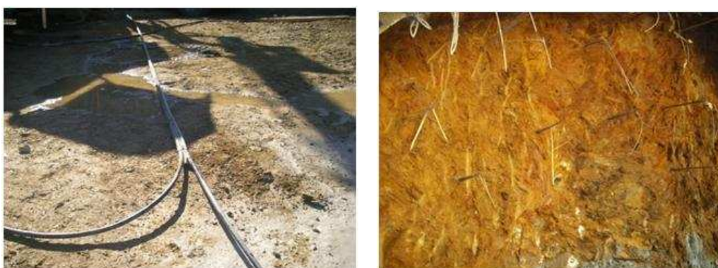
Figura 68 - Fibra Y35 pronto a ser colocada e vista de uma frente de escavação ZG3 com fibras de vidro instaladas.
