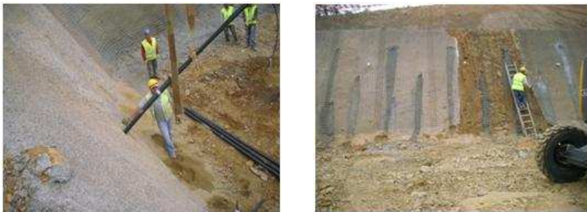
Figura 44 - Colocação de uma pregagem Diwidag, colocação de drenos.
