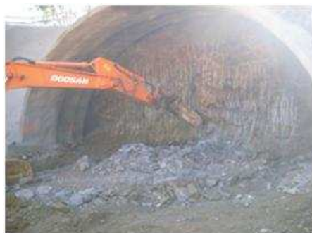
Figura 25 - Início da escavação da calote.
