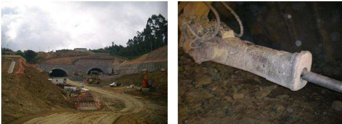
Figura 49 - Vista geral do emboquilhamento de saída com as duas galerias. Martelo hidráulico utilizado para escavação do maciço.
