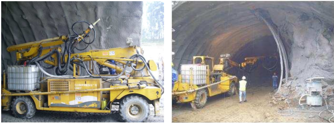
Figura 75 - SIKA PM 500 P Putzmeister em obra e durante operações de projecção.
