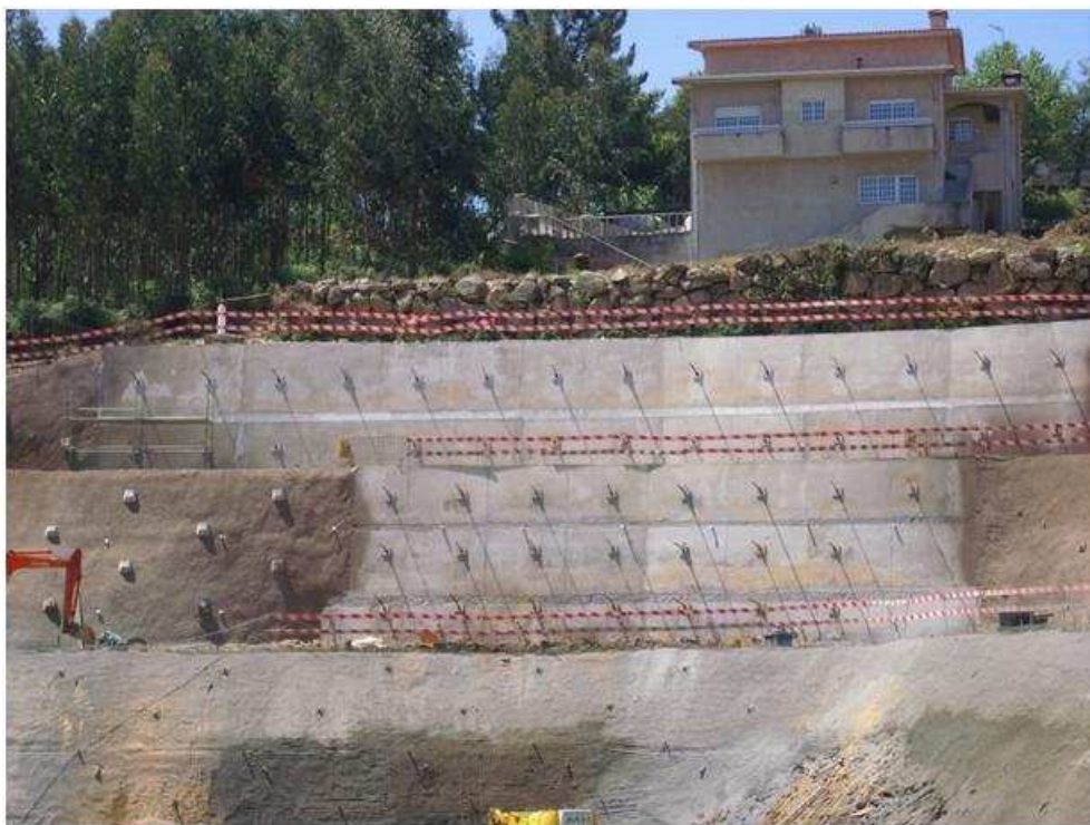
Figura 46- Vista da parede ancorada de betão desde o talude lateral norte.
