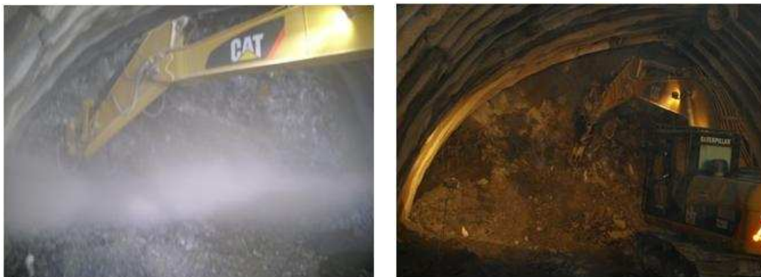
Figura 89 - Escavação sem ventilação vs escavação com ventilação.
