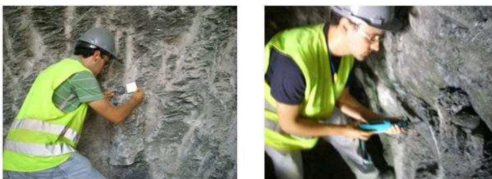
Figura 96 - Medição de orientação da discontinuidade numa frente de escavação e ressalto com o martelo SilverSchmidt para avaliação da resistência á compressão.
