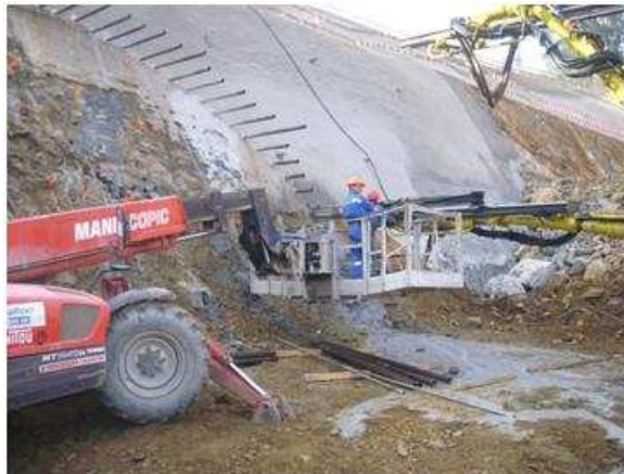
Figura 66 - Operação de colocação de microestacas com auxílio do multifunções.
