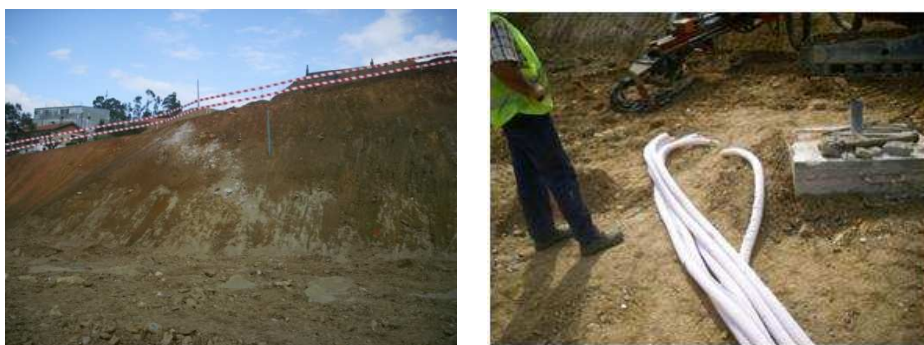
Figura 42 - Drenos envolvidos em geotêxtil e malha de drenos instalada no talude superior poente.
