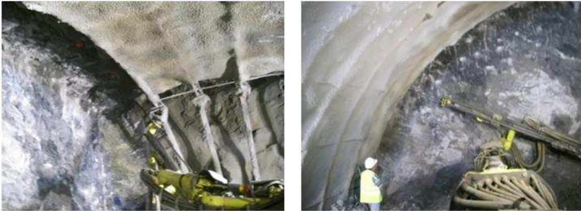
Figura 59 - Furação para instalação de Swellex.
