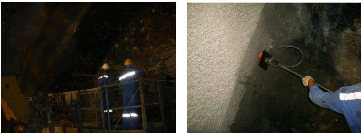
Figura 60 - Instalação do Swellex e injeção de água para sua expansão.
