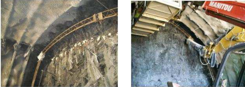
Figura 56 - vista do perfil montado e auxílio do martelo hidráulico na colocação dos perfis.
