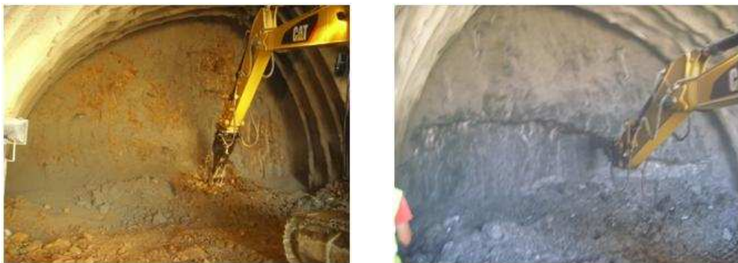
Figura 52 - Sequência de escavação segundo a orientação das descontinuidades, fase inicial e fase intermédia.
