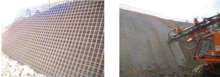
Figura 43 - – Rede electrosoldada, e furação para pregagens.
