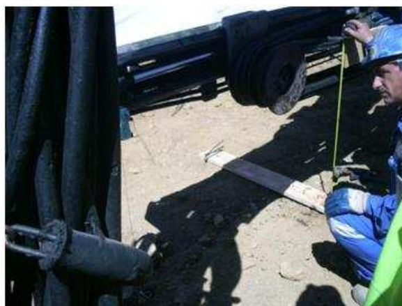
Figura 64 - Medição da altura ao nível da traseira da coluna de furação para furação.
