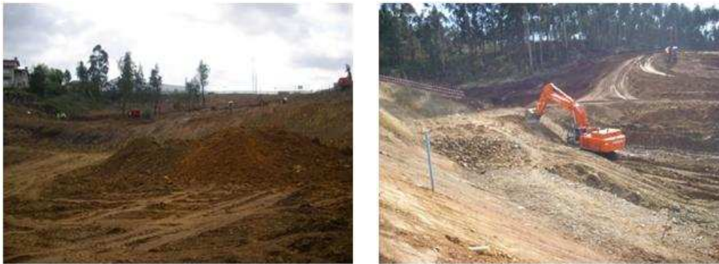
Figura 41 - Trabalhos de escavação e remoção de terras no emboquilhamento de entrada e de saída.
