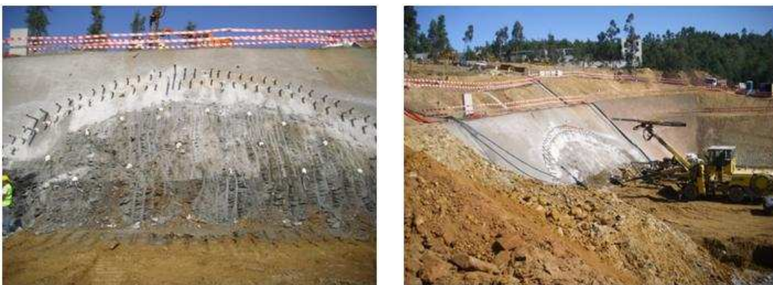
Figura 63 - Vista do emboquilhamento de saída do túnel com microestacas instaladas e início dos trabalhos de escavação com martelo hidráulico.
