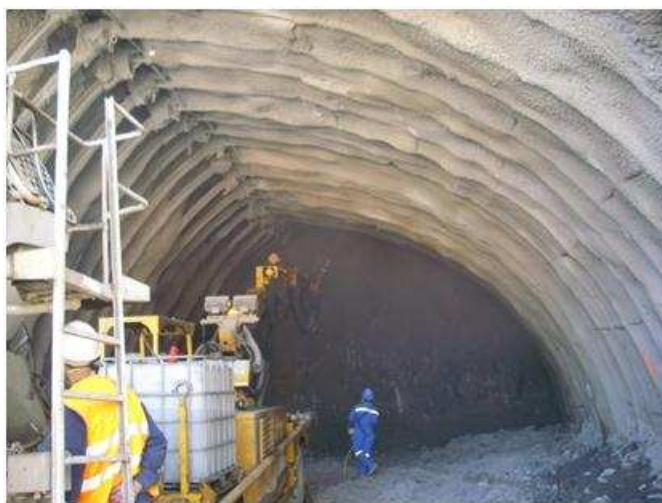
Figura 53 - Projecção de betão na galeria Sul do emboquilhamento de saída.
