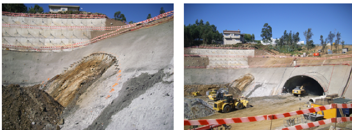
Figura 121 – Vista do lado nascente com as primeiras micro - estacas instaladas na galeria Nascente Sul.
