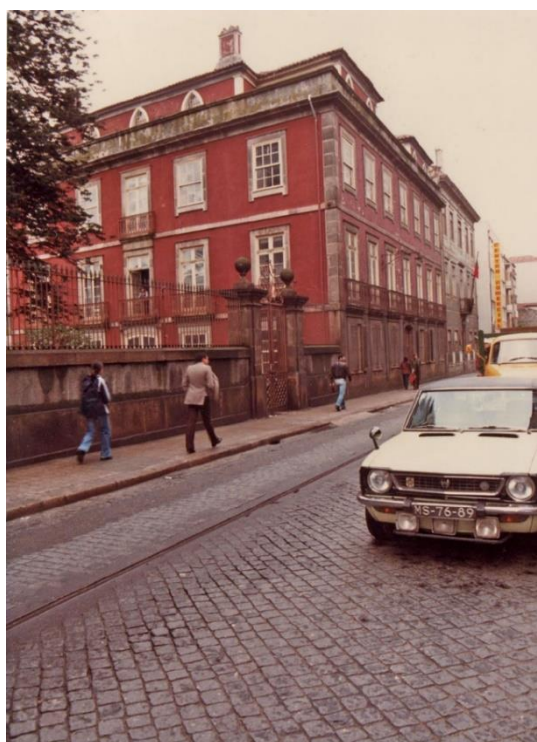
Figura 34 - Casa da Rua de Cedofeita
