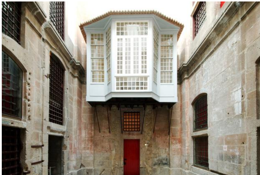
Figura 2 – Capela de Madeira do Centro Português de Fotografia (adossada à parede do saguão principal)
