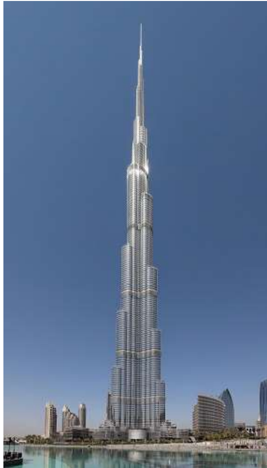
Figura 2.2.: Edifício mais alto do mundo BURJ KHALIFA (2010)
