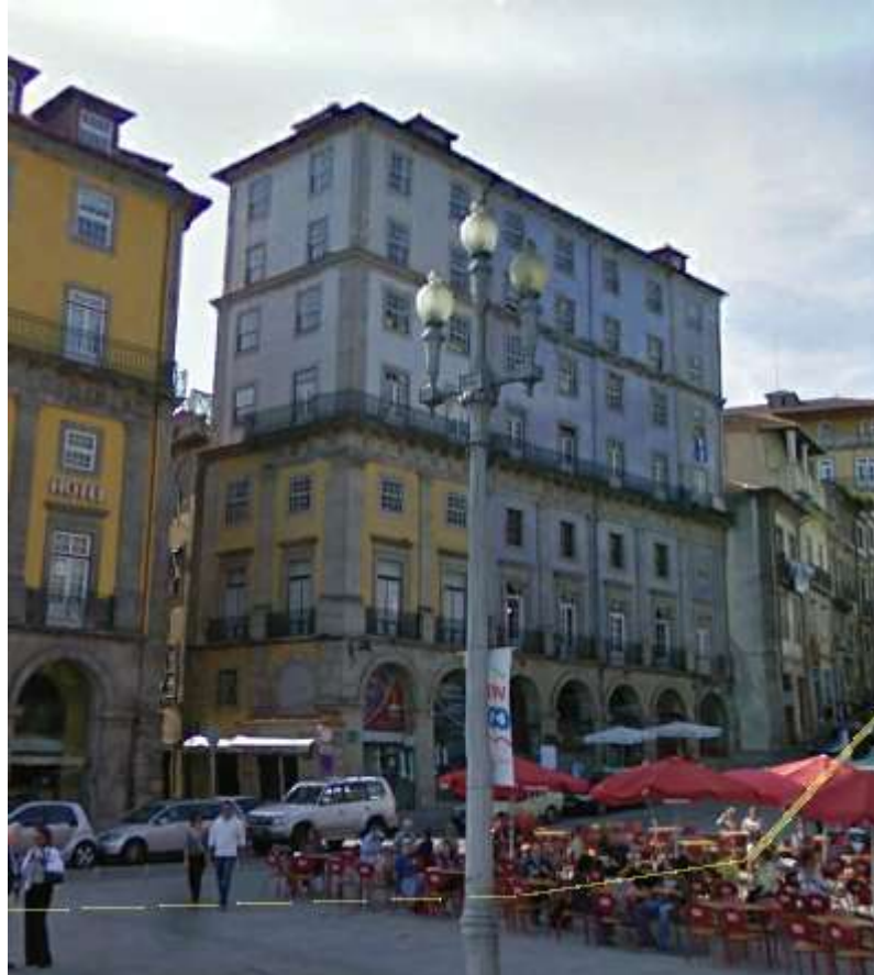
Figura 2.3.: Edifício alto na zona histórica do Porto
