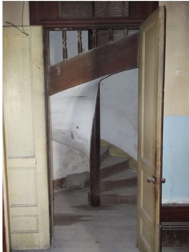
Figura 3.16.: Escada de Caracol numa arrecadação
