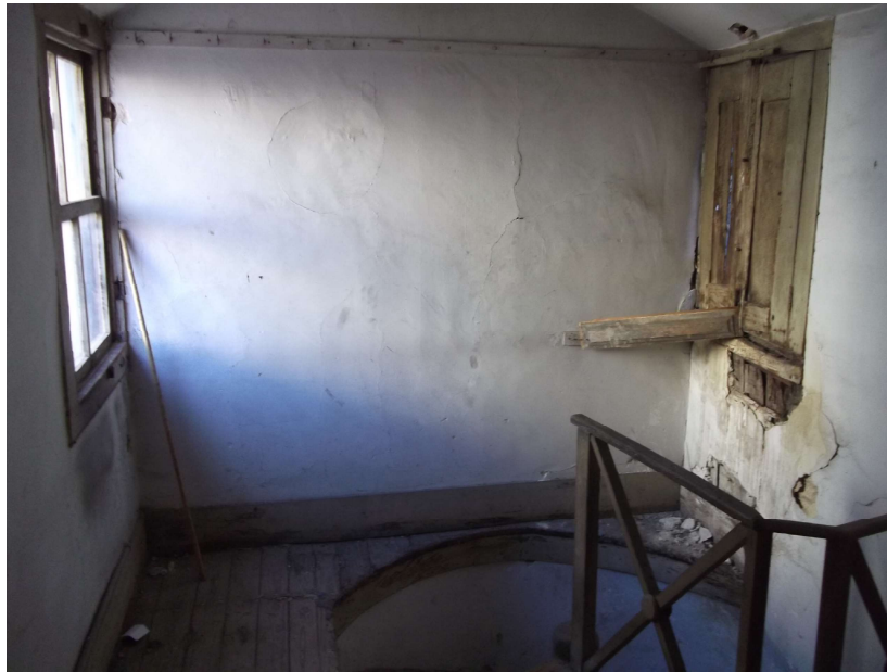
Figura 3.25.: Interior da caixa de escadas
