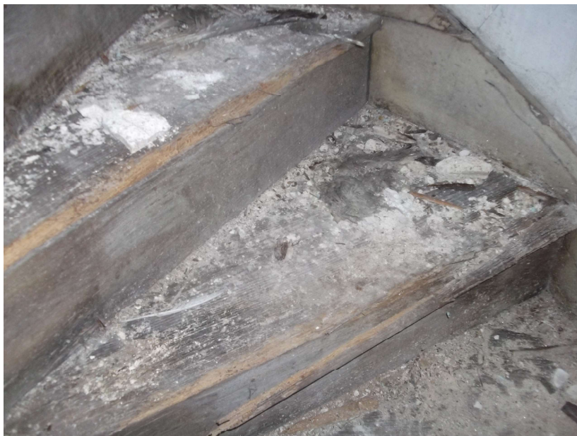
Figura 4.8.: Escada Caracol para acesso do 2º andar ao desvão da cobertura
