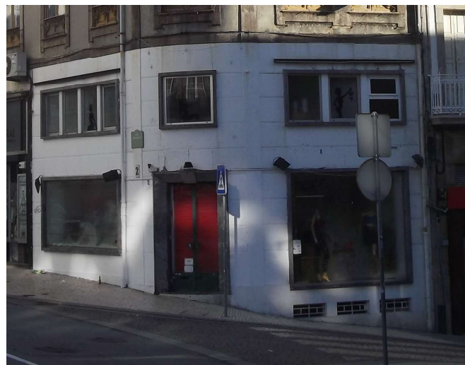
Figura 2.6.: Foto atual onde se pode ver um dos espaços comerciais com duas frentes, uma para a Rua José Falcão a poente e outra para a Rua da Fábrica a sul
