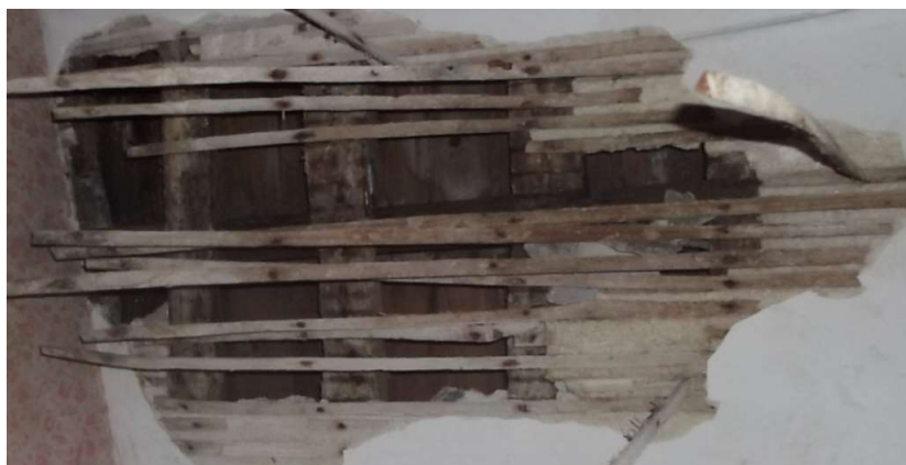
Figura 3.10.: Pormenor do Teto do 2º andar
