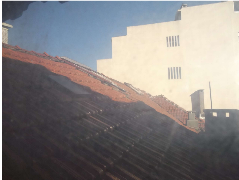
Figura 4.12.: Vista de parte do telhado, água nascente, apresentando bom aspeto
