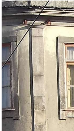
Figura 3.2.: Pormenor da Fachada Sul, onde podemos ver a pedra trabalhada à vista nas ombreiras dos vãos e cunhal entre as fachadas sul e poente
