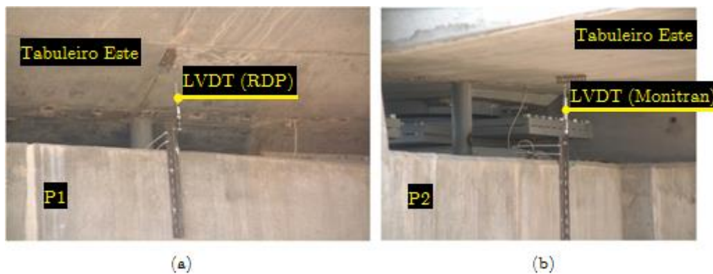
Figura 4.28 - Pormenor da aplicação dos LVDT's nos pilares intermédios P1 (a) e P2 (b) durante o ensaio de carga.
