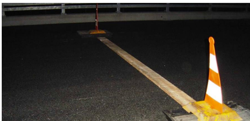
Figura 4.44 - Passagem com ressalto.
