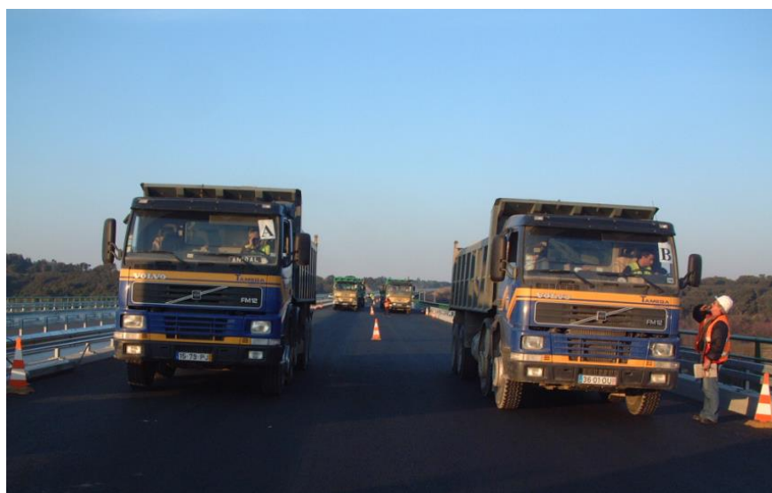
Figura 4.35 - Veículos utilizados durante o ensaio de carga da ponte sobre o rio Sorraia.
