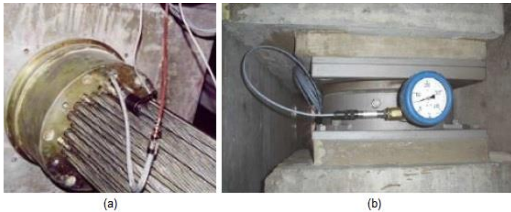
Figura 2.23 – Aplicação de células de carga (LNEC; Branco, 2011): (a) Medição de esforço normal em tirante com célula de carga elétrica; (b) Medição de reações de apoio com célula de carga hidráulica.
