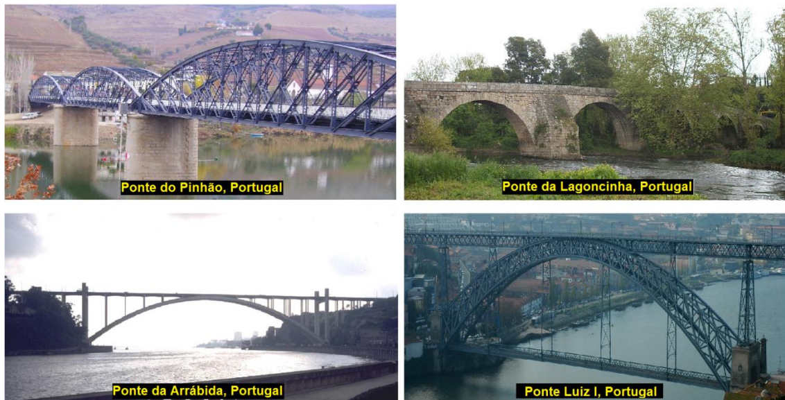
Figura 3.17 - Exemplos reais de pontes em arco.
