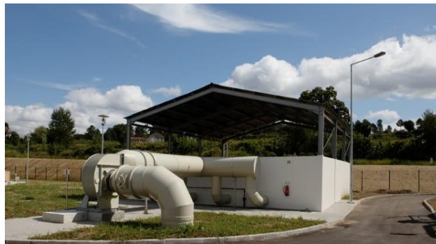
Figura 2.7. Edifício de desodorização da ETAR de Paço de Sousa.
