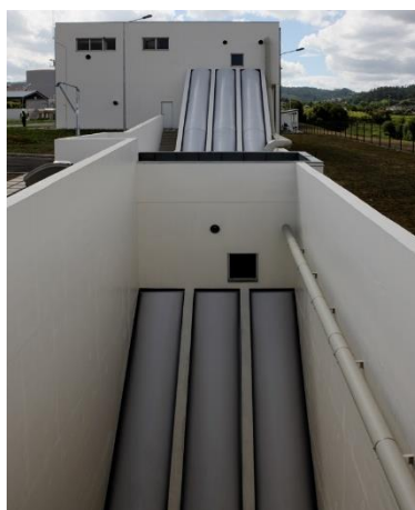
Figura 2.4. Elevação do afluente por dois estágios de parafusos de Arquimedes.
