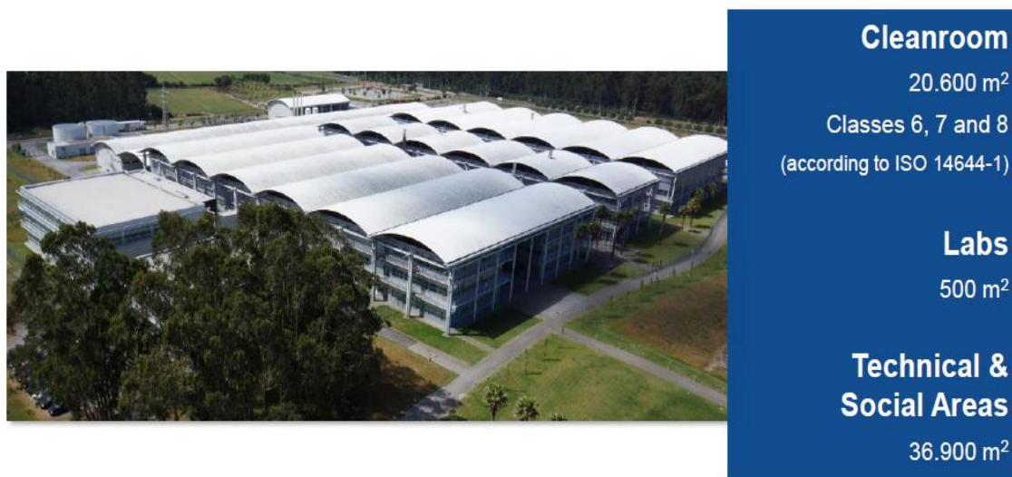
Figura 10 - Vista geral da Empresa ATEP (Fonte: ATEP (2019)).
