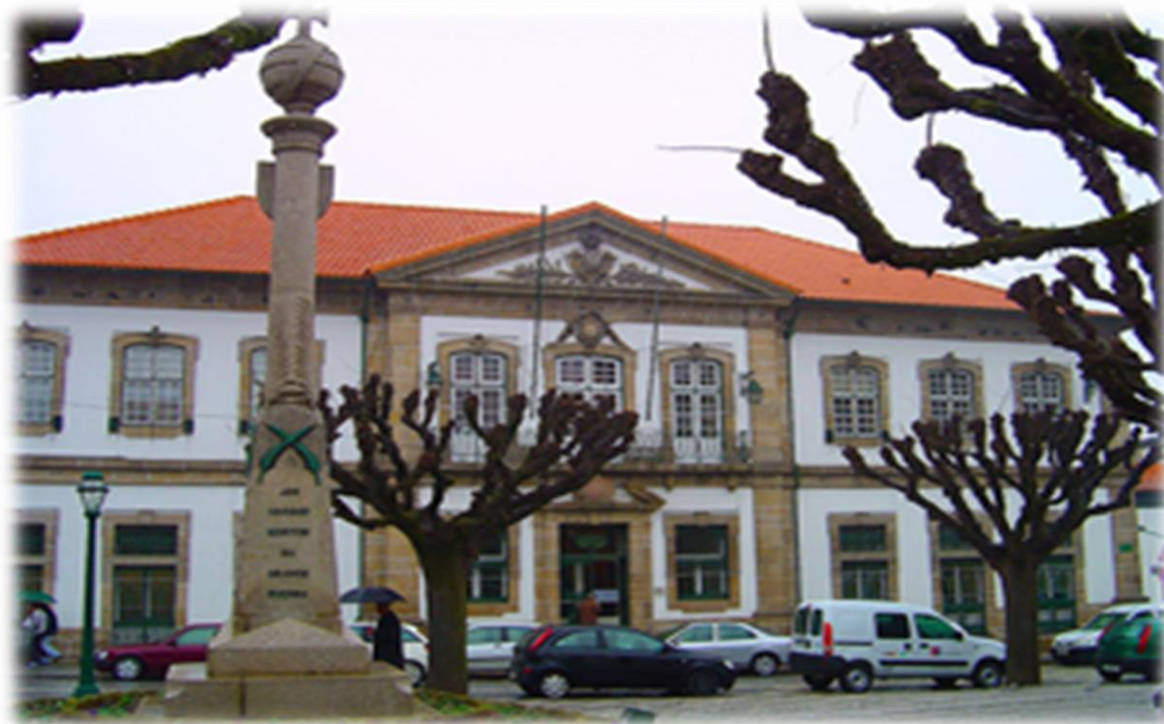
FIGURA 2 – CÂMARA MUNICIPAL DE PENAFIEL
