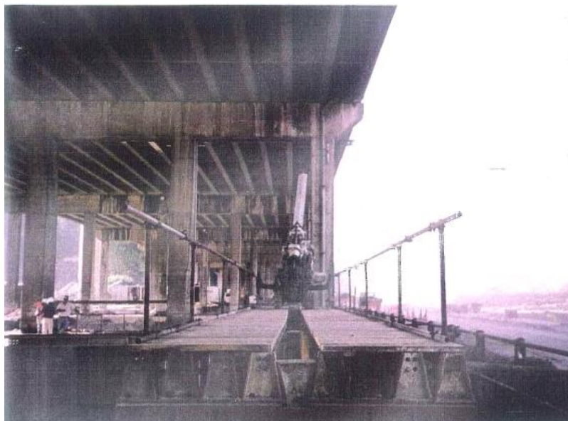
Figura 17 - Laje de soleira em Jet Grouting. (APDL)
