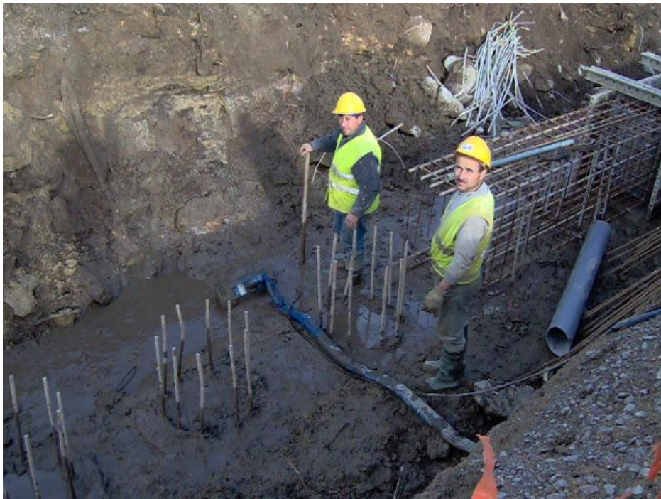
Figura 19 - Execução da cortina de estacas.(APDL)
