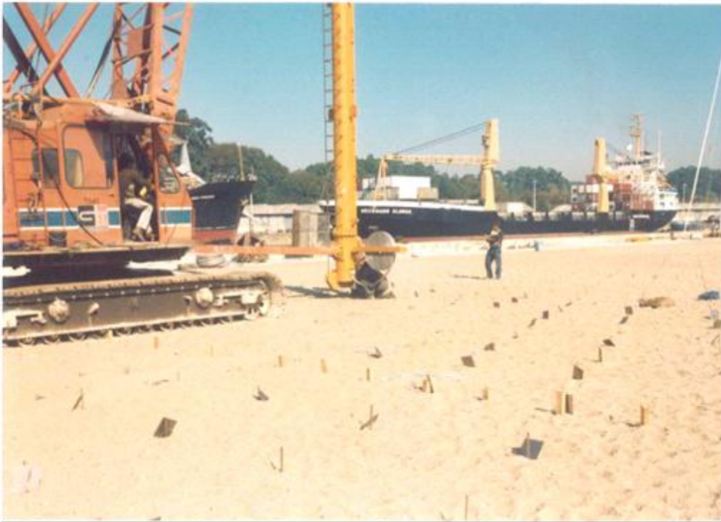
Figura 13 - Drenos instalados no terreno (APDL)
