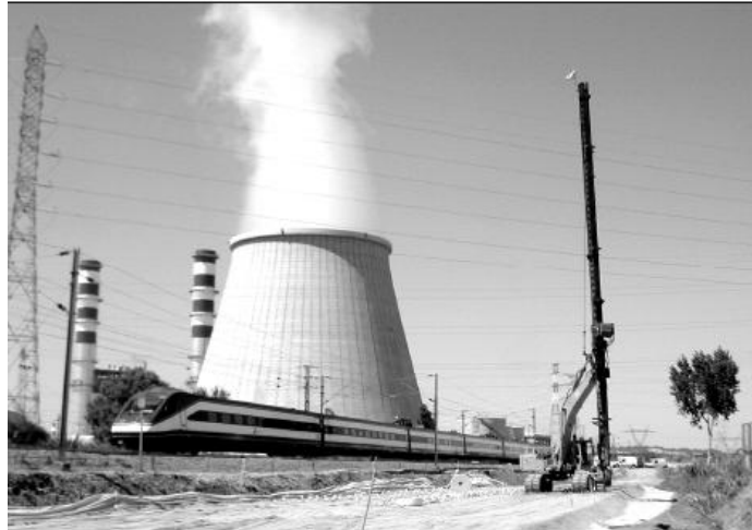
Figura 9 -Execução de geodrenos verticais no troço junto à Central Térmica do Carregado.( www.geomuseu.ist.utl.pt (Setembro de 2009))
