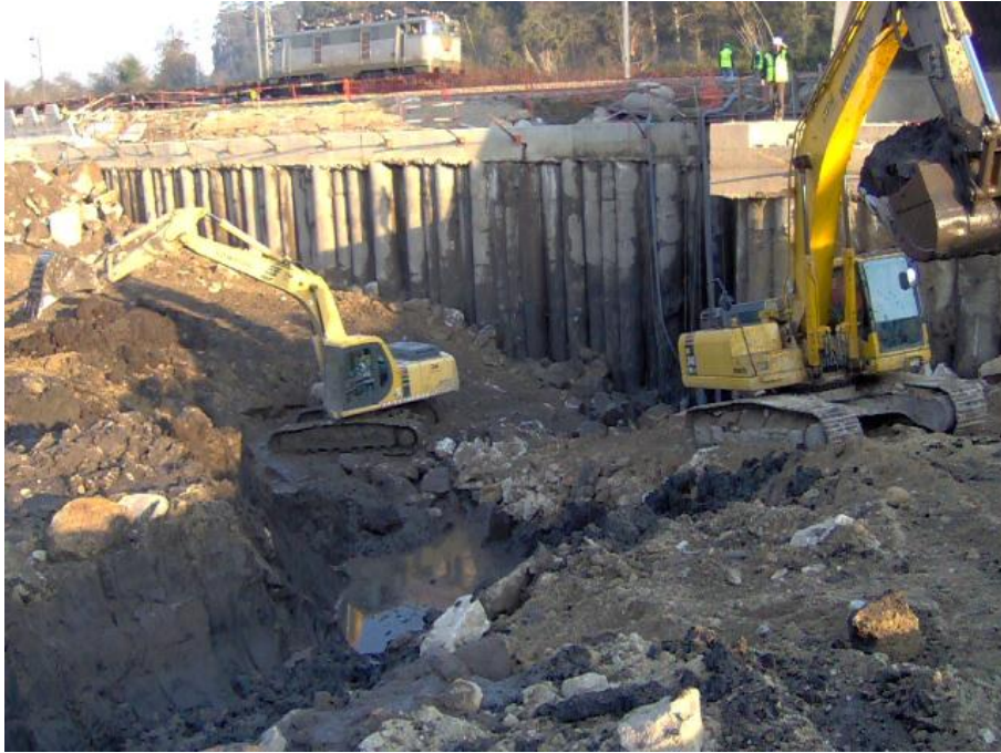
Figura 21 - Escavação até à cota final.
