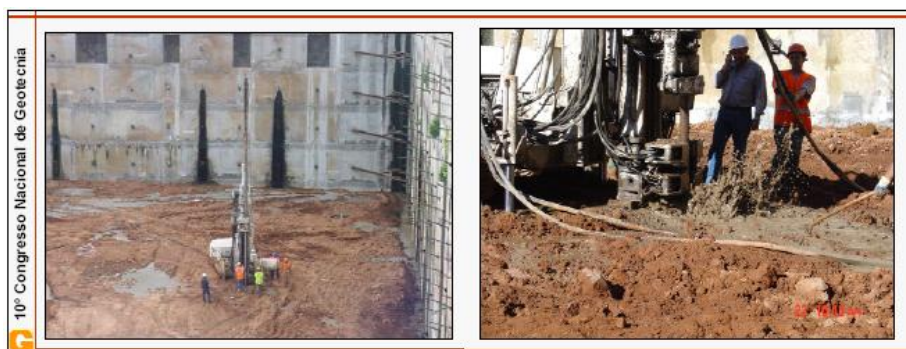
Figura 10- Execução das colunas de Jet grouting. (www.geomuseu.ist.utl.pt (Setembro de 2009))
