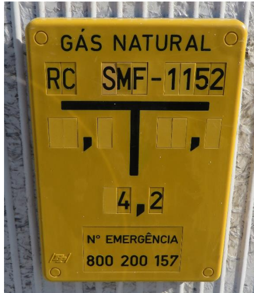
Figura 33 – Placa de Presença de Rede de GN na rua da escola.
