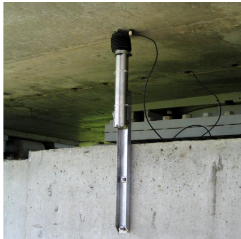
Figura 2.10 - Colocação de um LVDT em obra.
