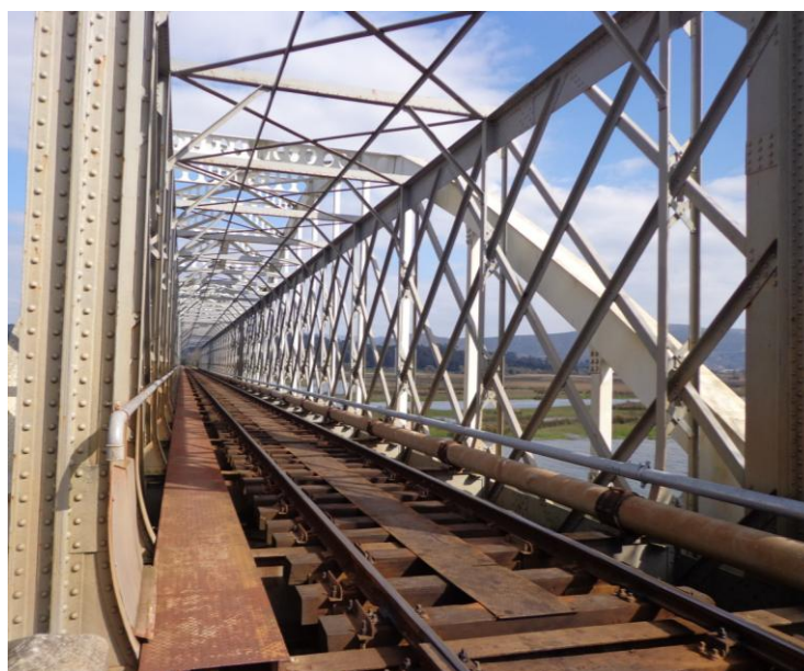
Figura 5.3 - Viga de treliça de rótula múltipla fechada superiormente da estrutura original.
