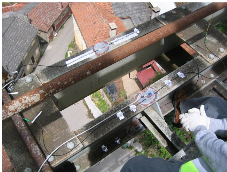
Figura 2.7 - Colocação em obra de um extensómetro elétrico (cabo branco) e de um extensómetro em fibra ótica (cabo preto).
