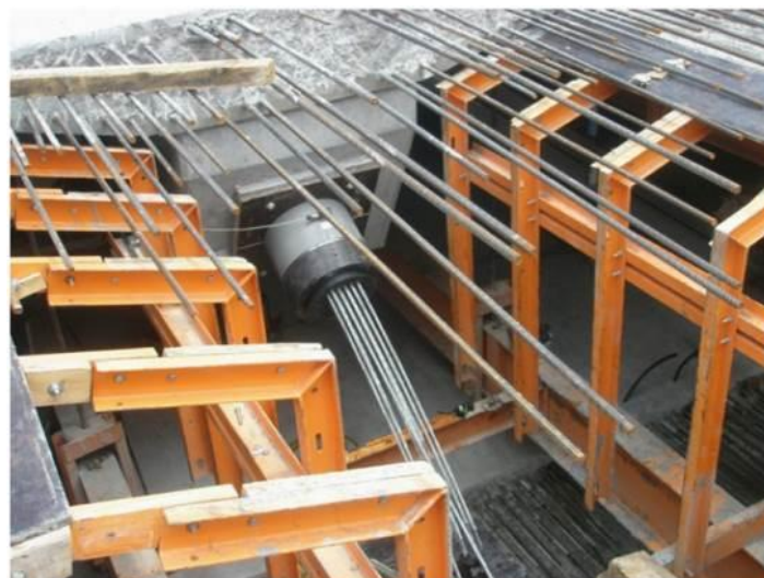
Figura 2.14 - Colocação de célula de carga em obra.
