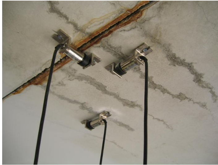
Figura 2.8 - Colocação de transdutores de deslocamento resistivos em obra.
