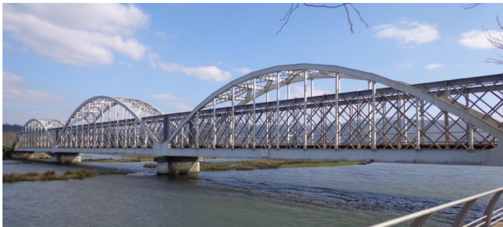
Figura 5.4 - Ponte sobre o rio Coura reforçada com viga do tipo "Bowstring Langer".
