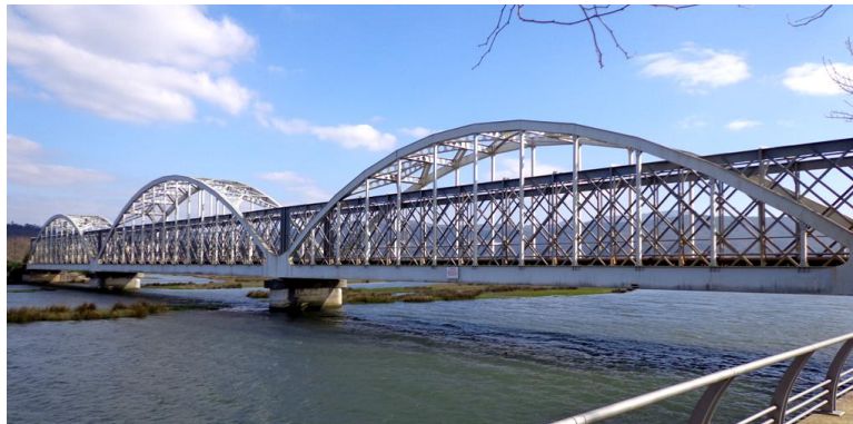
Figura 5.1 - Ponte ferroviária sobre o rio Coura.
