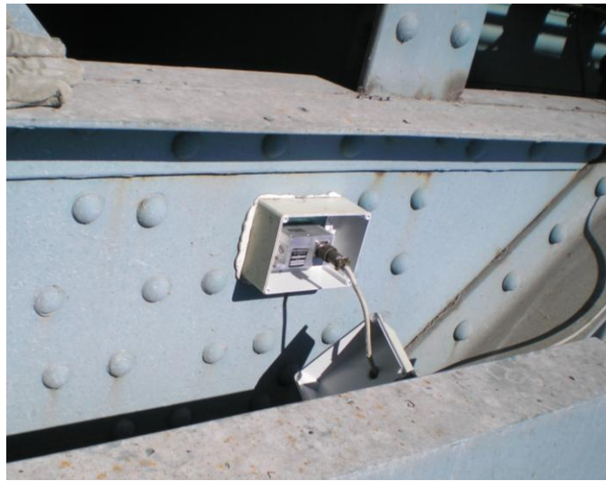
Figura 2.13 - Colocação de um inclinómetro elétrico em obra.
