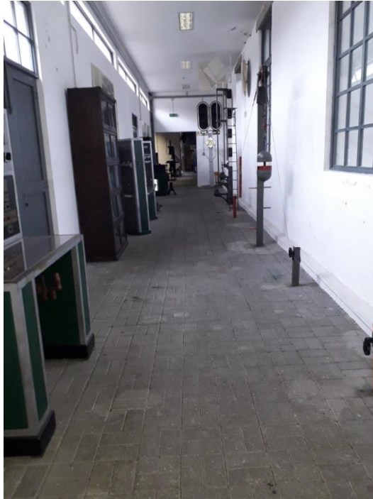
Figura 62 - Mobiliário e Sinalização. Autor: Paulo Ribeiro
