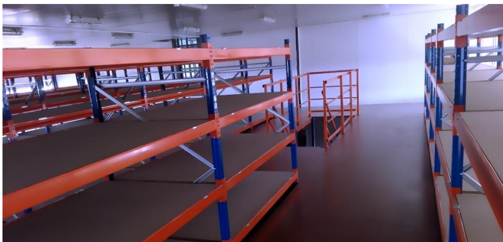
Figura 33 - Exemplo das racks adquiridas (Norrack, 2021)
