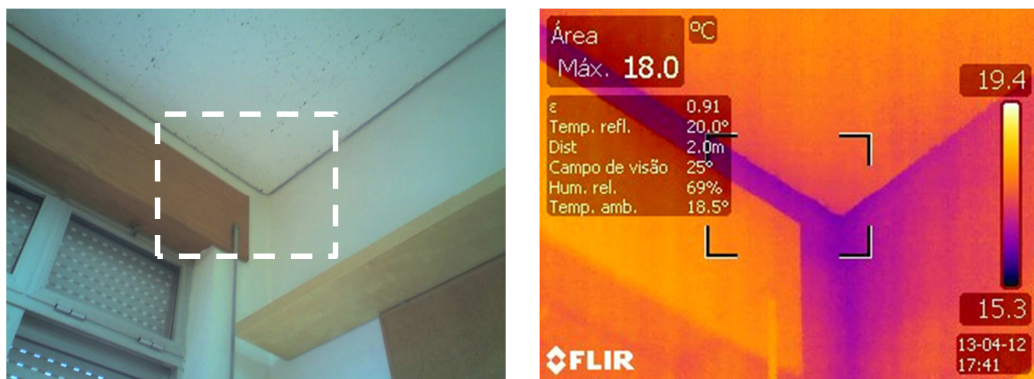
Figura 5.20: Registo termográfico do canto superior, da parede exterior, da sala de aula da escola ESV.
