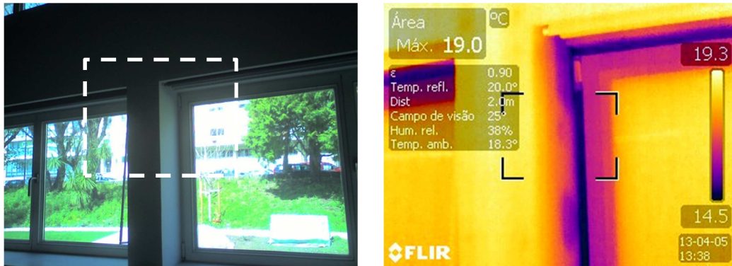
Figura 5.24: Registo termográfico de um vão exterior da sala de aula da escola ESCR.
