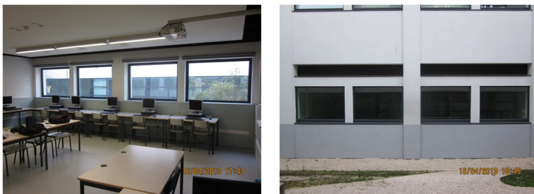
Figura 5.11: Registo fotográfico da envolvente exterior da sala de aula da escola ESSR.
