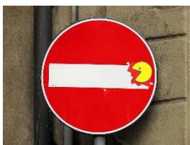
Figura 106 – Sinal (C1 – Sentido Proibido) vandalizado
