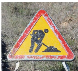
Figura 105 – Sinal (A23 – Trabalhos na via) deteriorado
