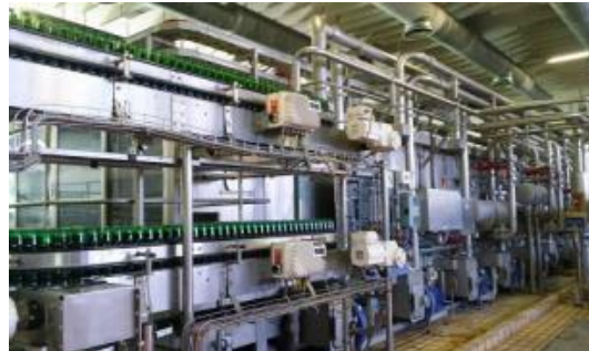
Figura 2.10 Pasteurizador da linha 6 [10].
